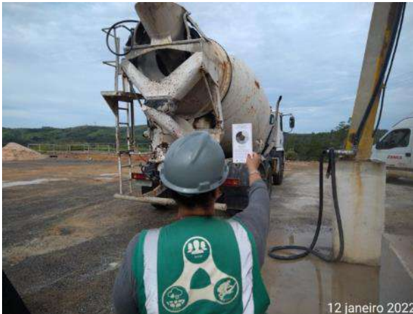
Foto 401 – Medição de fumaça preta em caminhão betoneira. (Data:12/01/2022)
