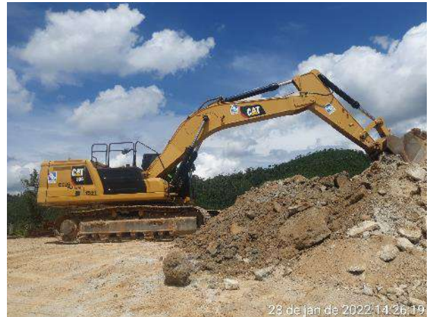
Foto 162 – Reaproveitamento de material inerte para melhoria de vias internas. (Data:28/01/2022)
