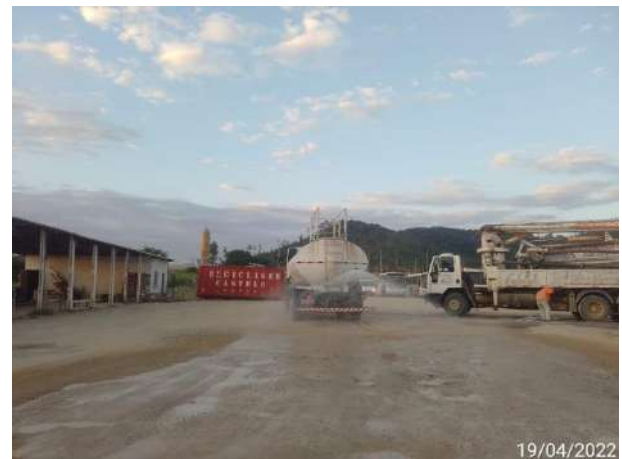
Foto 396 – Umectação nas vias internas. (Data:19/04/2022)
