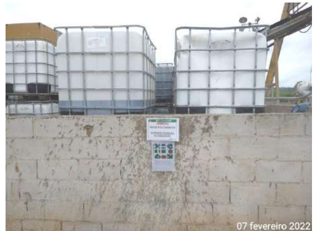
Foto 66 – Aditivos da usina de concreto, dentro da área de contingência. (Data:07/02/2022)
