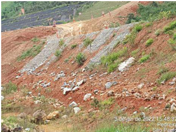
Foto 288 – Correção das erosões em talude do acesso para margem direita. (Data:03/01/2022)
