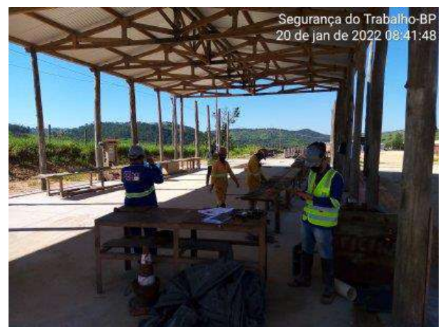
Foto 170 – Inspeção de frente de serviço, área de armação. (Data:20/01/2022)
