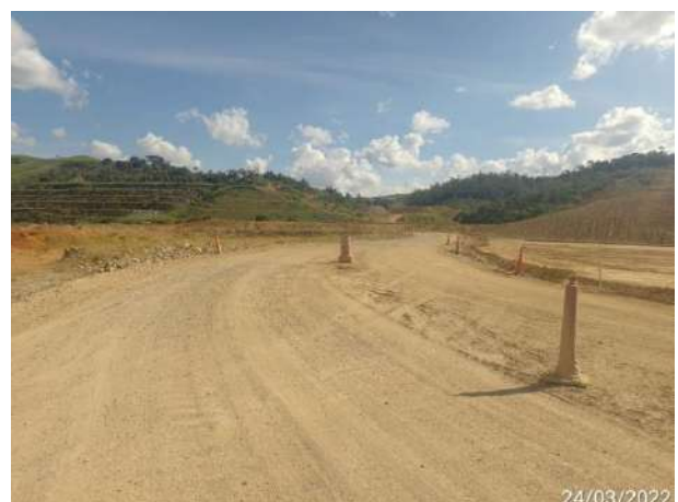
Foto 285 – Sinalização de cones nos caminhos de serviço. (Data:24/03/2022)
