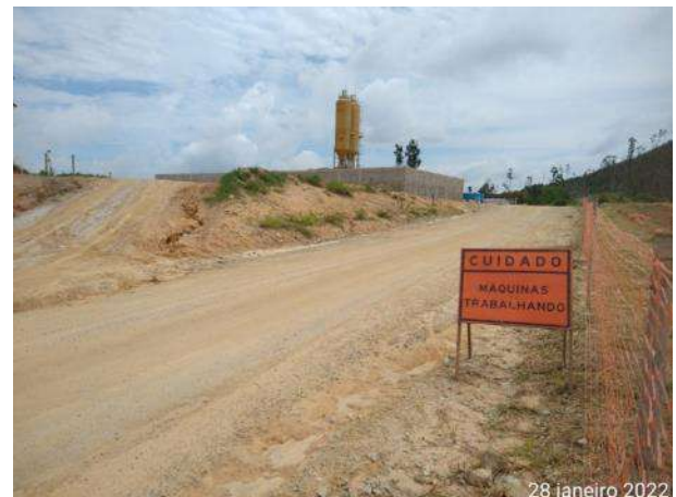
Foto 271 – Sinalização de máquinas trabalhando no local. (Data:28/01/2022)
