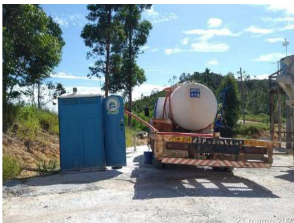
Foto 375 – Higienização de banheiro químico na frente de serviço. (Data:21/03/2022)
