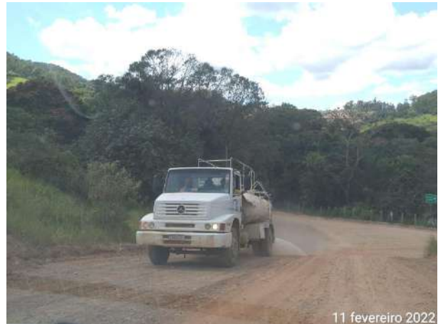
Foto 388 – Umectação nas vias internas. (Data:11/02/2022)
