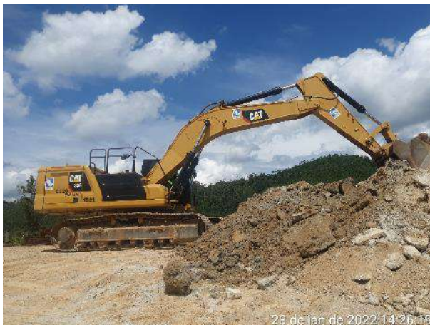
Foto 292 – Utilização de material inerte para melhoramento das vias internas. (Data:28/01/2022)
