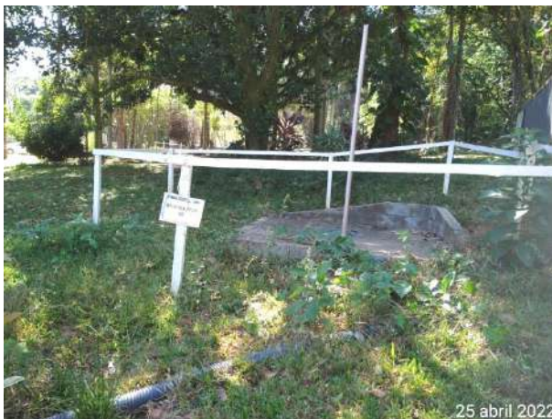
Foto 384 – Biodigestor 02 no canteiro administrativo. (Data:25/04/2022)
