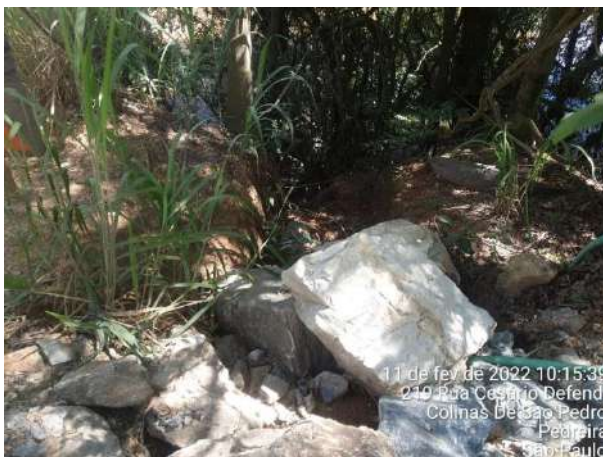
Foto 331 – Inspeção em drenagem provisória – acesso margem esquerda. (Data: 11/02/2022)
