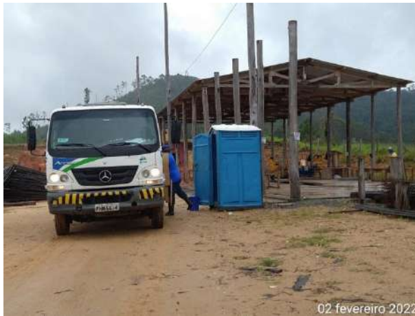
Foto 367 – Higienização de banheiro químico na frente de serviço. (Data:02/02/2022)
