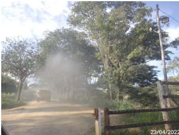
Foto 399 – Umectação nas vias internas. (Data:23/04/2022)
