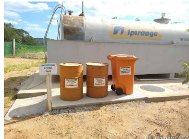
Foto 89 – Kit de emergência ambiental no posto de abastecimento. (Data:09/02/2022)
