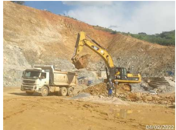
Foto 464 – Limpeza rigorosa margem direita. (Data:04/02/2022)
