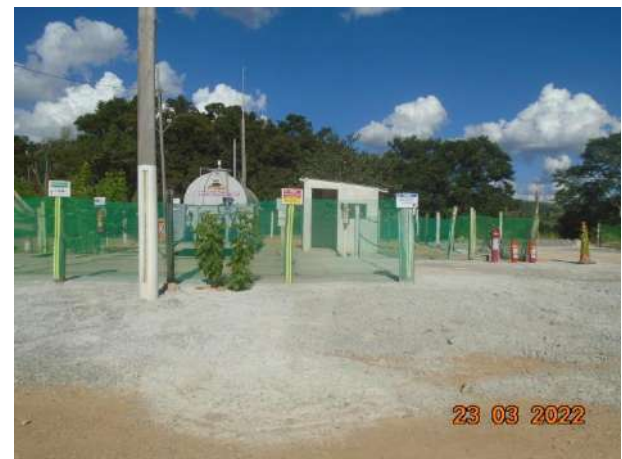
Foto 166 – Sobra de concreto utilizado para piso do ponto de abastecimento. (Data:23/03/2022)
