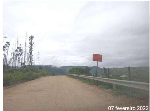
Foto 254 – Sinalização de entrada e saída de veículos pesados. Data: (07/02/2022)
