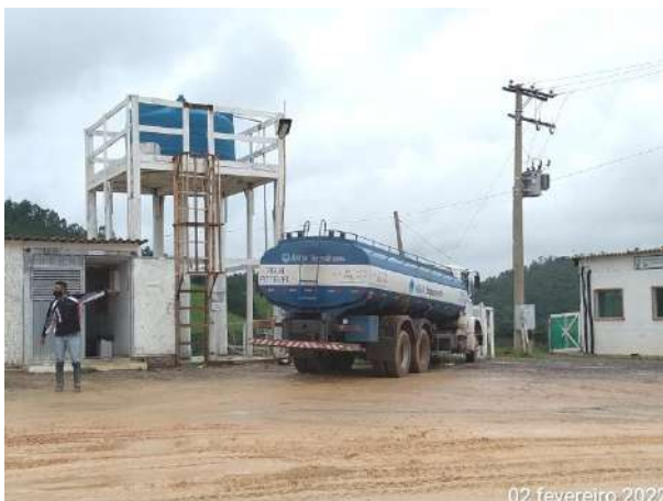
Foto 149 – Abastecimento da caixa de água do canteiro operacional. (Data:02/02/2022)
