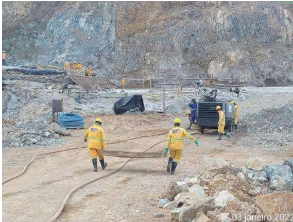
Foto 81 – Movimentação de equipamento juntamente com bandeja de contenção ambiental. (Data:03/01/2022)
