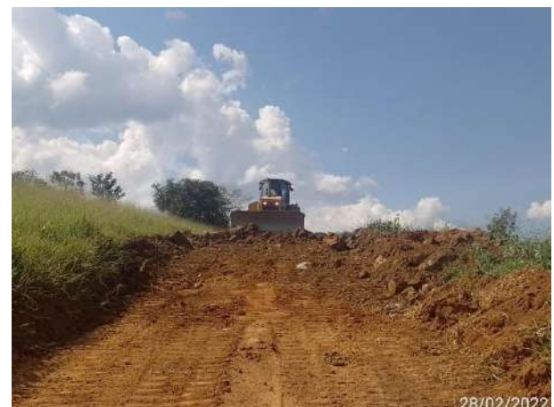
Foto 279 – Melhoramento em via interna – lote 7. (Data:28/02/2022)
