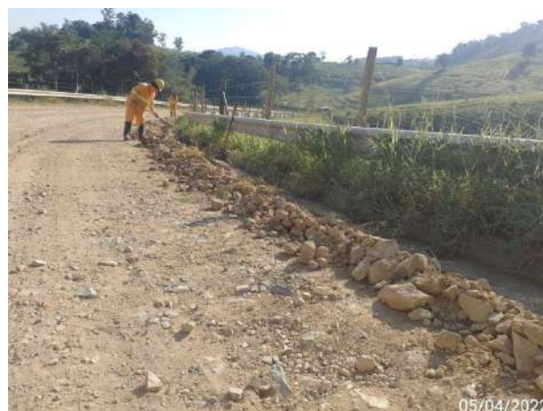
Foto 315 – Limpeza da drenagem na MD03. (Data:05/04/2022)
