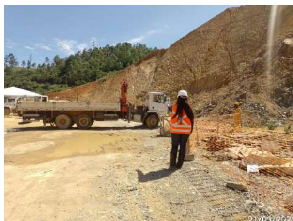
Foto 414 – Medição de fumaça preta em muncck. (Data:21/03/2022)
