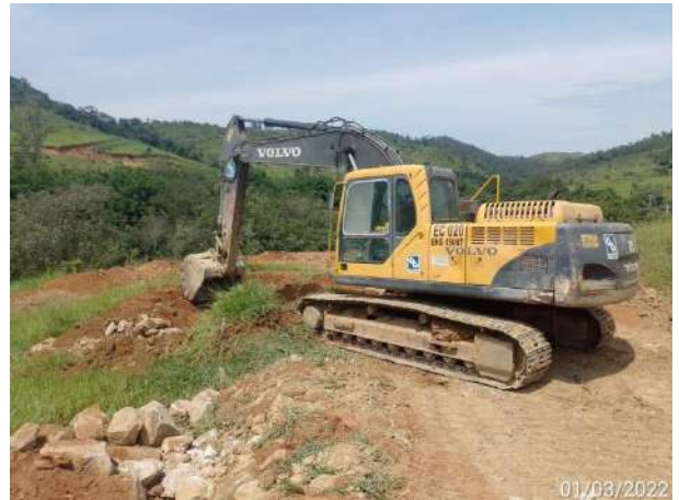
Foto 309 – Limpeza da drenagem na ME. (Data:01/03/2022)
