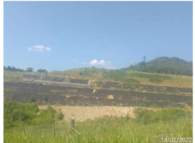
Foto 334 – Inspeção no bota-fora VII da margem direita. (Data:14/02/2022)
