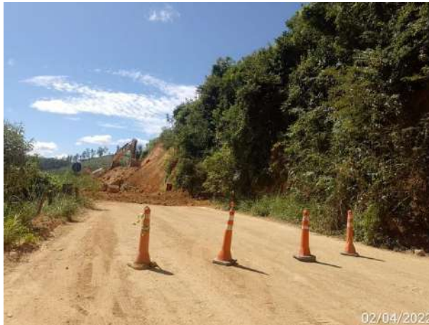
Foto 286 – Sinalização com cones durante atividade no acesso a fundação. (Data:02/04/2022)
