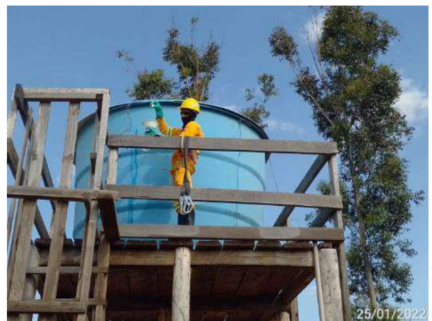
Foto 148 – Adequação de dosagem de cloro na caixa de água do laboratório. (Data:25/01/2022)
