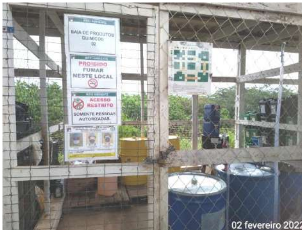
Foto 65 – Baía de produtos químicos no pátio da oficina mecânica. (Data:02/02/2022)
