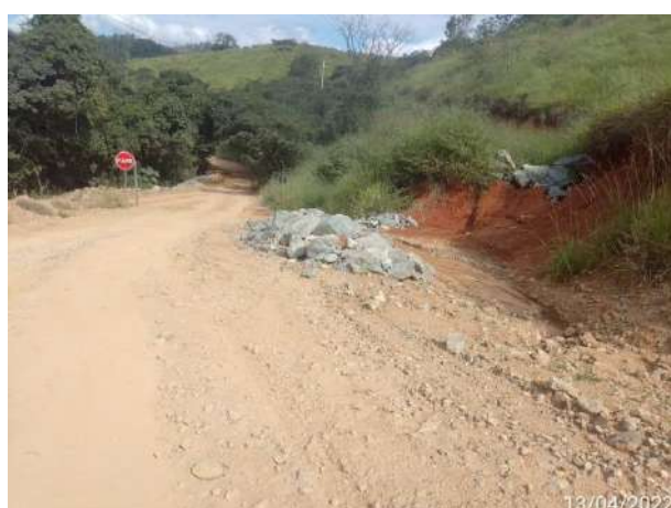
Foto 318 – Limpeza de drenagem M.D.03. (Data:13/04/2022)
