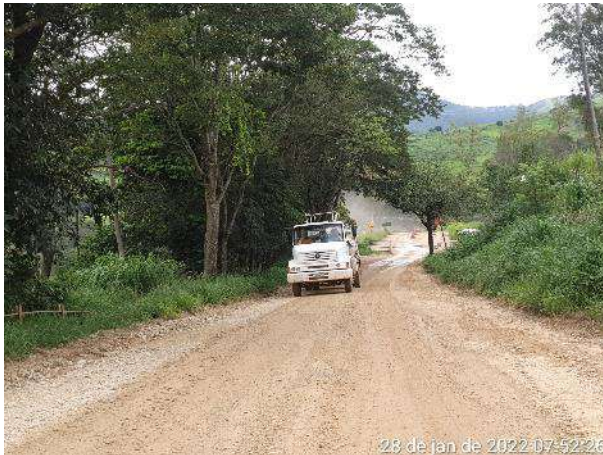
Foto 387 – Umectação nas vias internas. (Data:28/01/2022)
