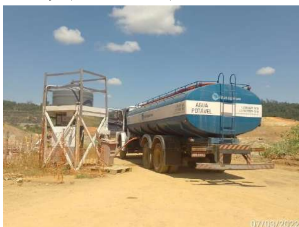
Foto 153 – Abastecimento da caixa de água das frentes de serviço. (Data:07/03/2022)
