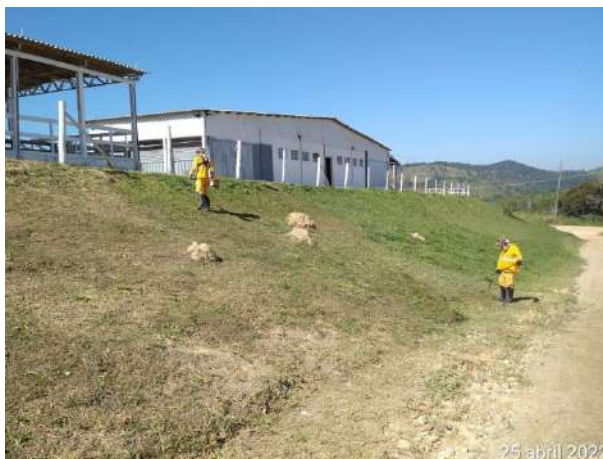
Foto 143 – Roçagem no canteiro operacional. (Data:25/04/2022)
