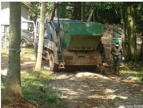
Foto 443 – Troca de caçambas de resíduo comum no canteiro administrativo. (Data:08/03/2022)
