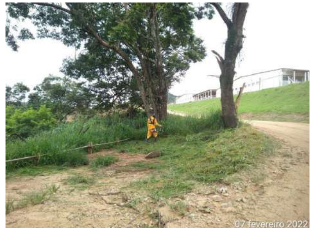
Foto 112 – Roçagem no canteiro industrial. (Data:07/02/2022)
