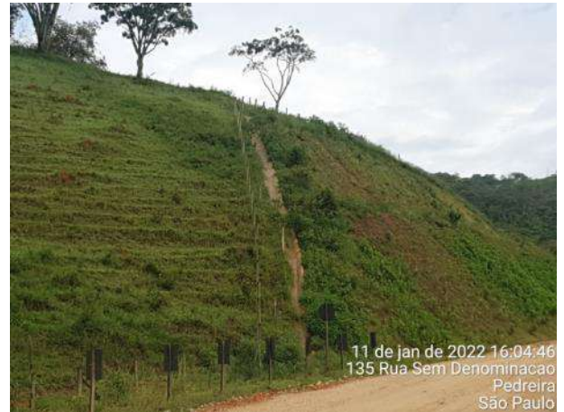
Foto 322 – Monitoramento de drenagem na M.D.03, dia de chuva. (Data:11/01/2022)
