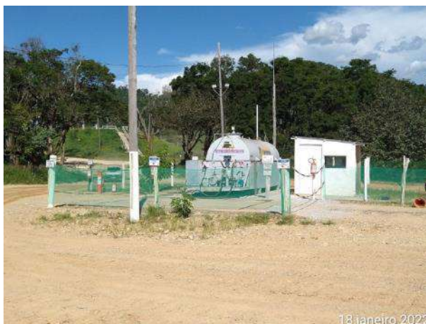
Foto 63 – Ponto de abastecimento no pátio da oficina mecânica. (Data:18/01/2022)
