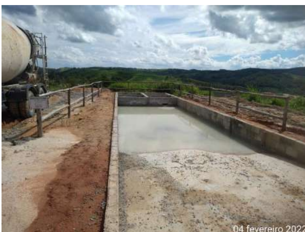
Foto 351 – Área para lavagem de calha de betoneira – usina de concreto. (Data:04/02/2022)
