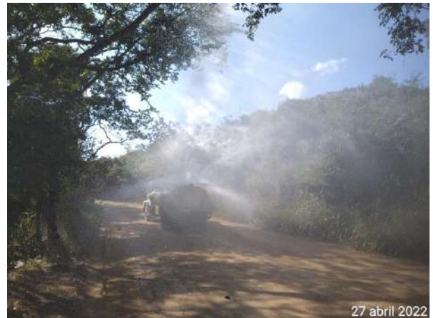
Foto 400 – Umectação nas vias internas. (Data:27/04/2022)
