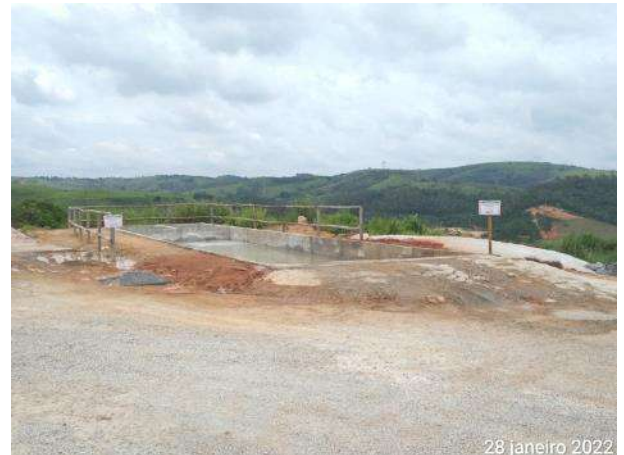
Foto 348 – Área para lavagem de calha de betoneira – usina de concreto. (Data:28/01/2022)
