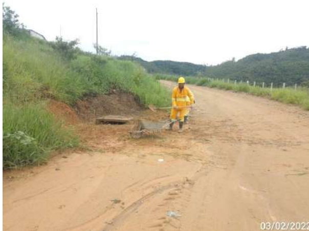
Foto 296 – Limpeza da drenagem na MD01. (Data:03/02/2022)
