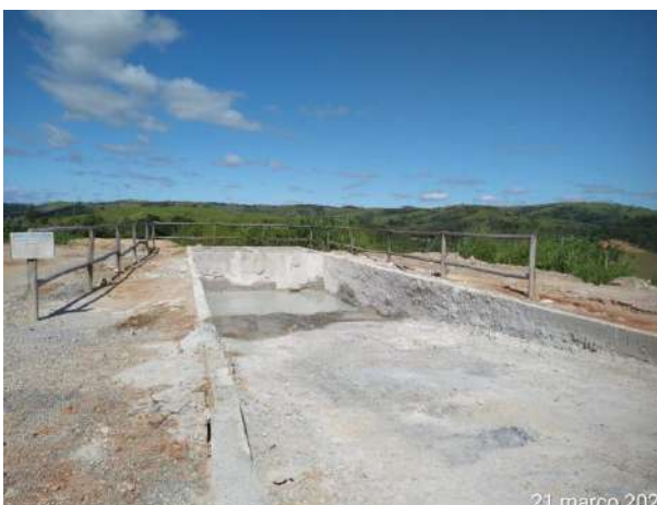
Foto 357 – Área para lavagem de calha de betoneira – usina de concreto. (Data:21/03/2022)
