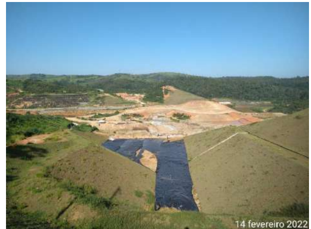
Foto 305 – Proteção em área exposta da ombreira direita. (Data:14/02/2022)
