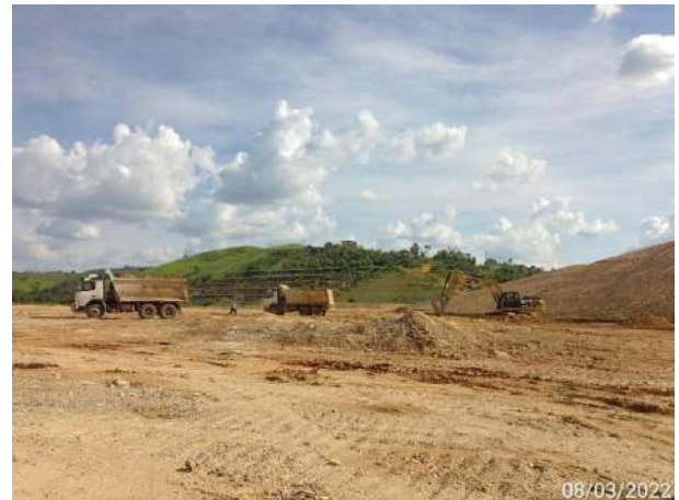
Foto 466 – Limpeza rigorosa margem direita. (Data:08/03/2022)
