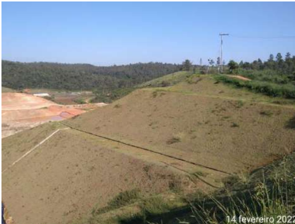
Foto 333 – Inspeção de drenagem definitiva na margem direita. (Data:14/02/2022)
