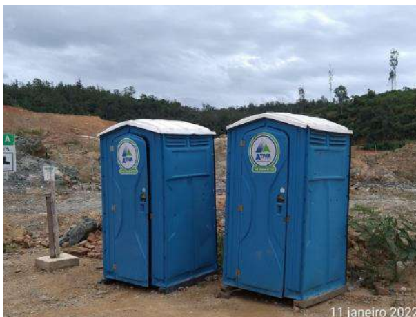
Foto 363 – Banheiro químico na frente de serviço. (Data:11/01/2022)
