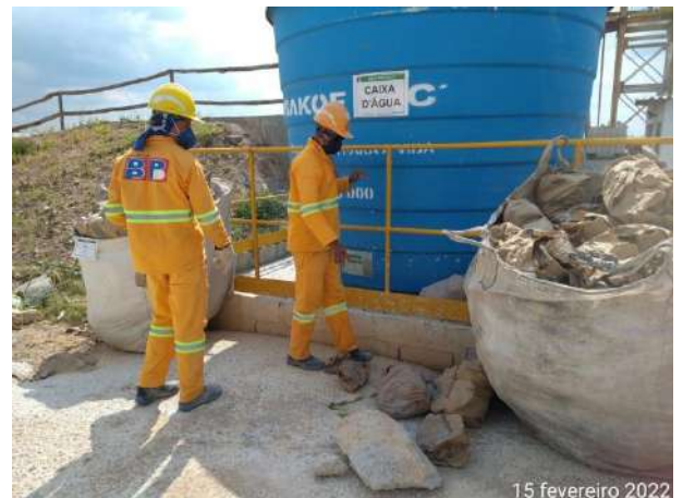
Foto 114 – Limpeza e organização na usina de concreto. (Data:15/02/2022)
