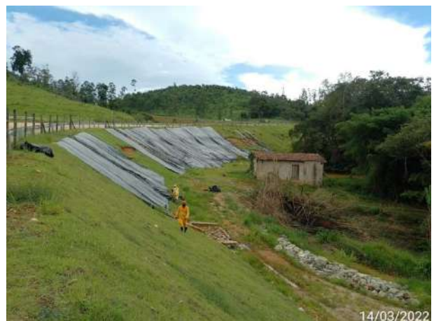
Foto 313 – Proteção de talude - MD03. (Data:14/03/2022)
