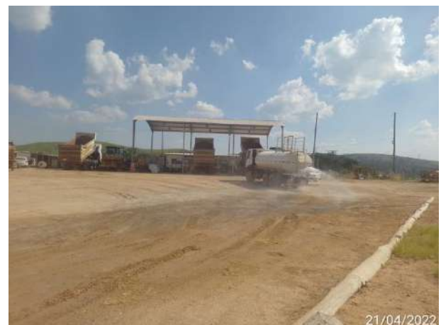
Foto 398 – Umectação nas vias internas. (Data:21/04/2022)
