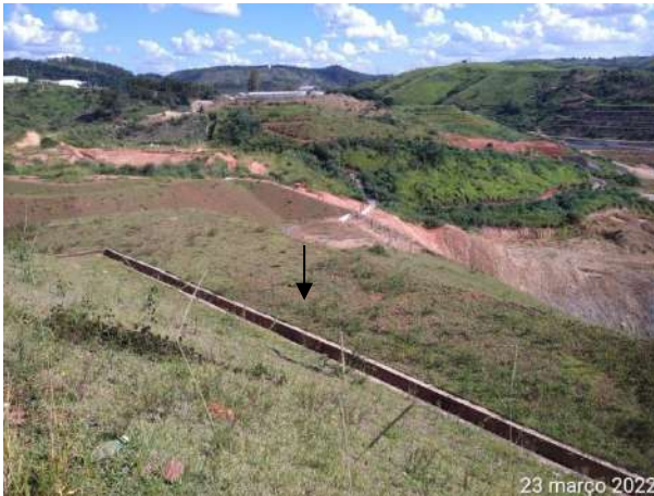
Foto 339 – Inspeção de drenagem definitiva na margem direita. (Data:23/03/2022)
