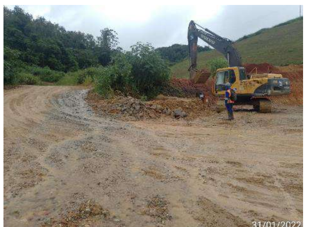
Foto 295 – Implantação de cacimba para redução da velocidade da água na margem direita. (Data:31/01/2022)
