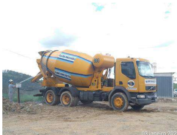
Foto 346 – Área para lavagem de calha de betoneira – canteiro industrial. (Data:03/01/2022)
