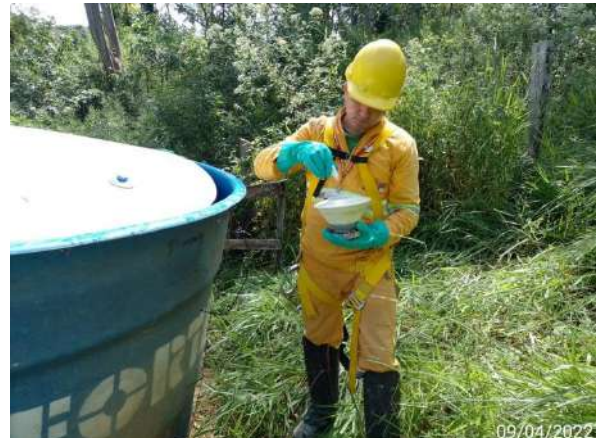
Foto 158 – Adequação de dosagem de cloro na caixa de água da base de fauna. (Data:09/04/2022)
