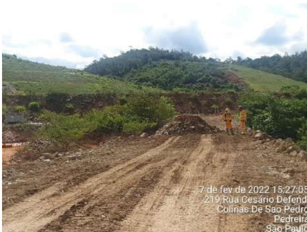
Foto 276 – Melhoramento em via interna de retorno da ombreira direita. (Data:07/02/2022)
