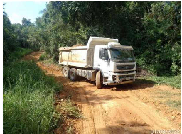
Foto 281 – Melhoria em via interna – lote 5 de plantio. (Data:01/03/2022)
