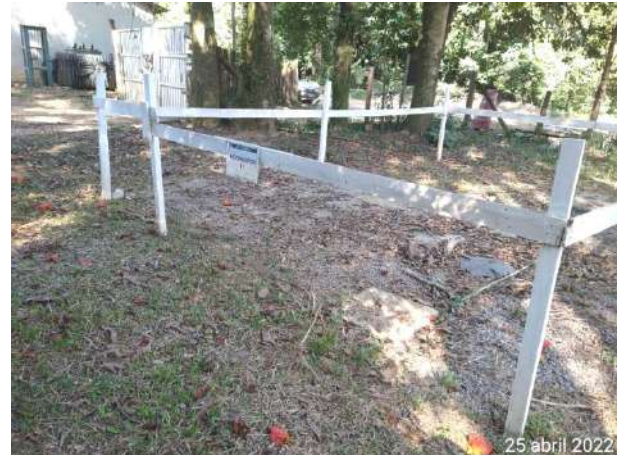
Foto 383 – Biodigestor 01 no canteiro administrativo. (Data:25/04/2022)
