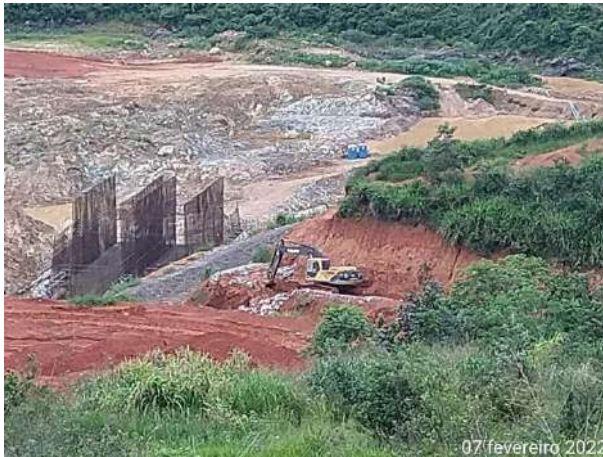
Foto 302 – Regularização de talude próximo a drenagem provisória da margem direita. (Data:07/02/2022)
