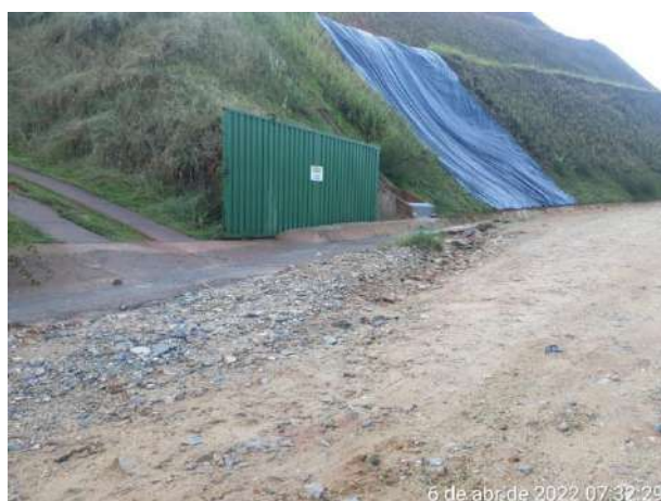
Foto 316 – Proteção de talude - MD03. (Data:06/04/2022)
