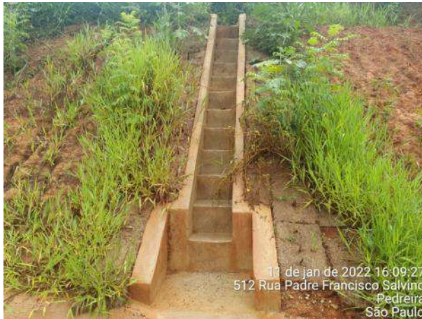
Foto 321 – Monitoramento de escada hidráulica na MD03, dia de chuva. (Data:11/01/2022)
