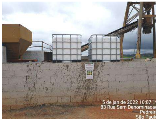
Foto 61 – Produtos devidamente rotulados em área adequada. (Data:05/01/2022)
