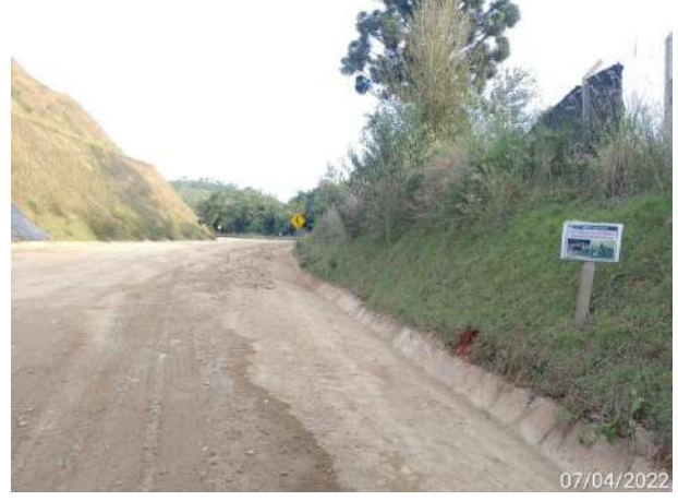
Foto 342 – Inspeção em talude – MD03. (Data: 07/04/2022)
