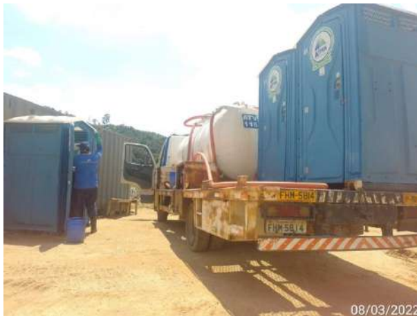
Foto 373 – Higienização de banheiro químico na frente de serviço. (Data:08/03/2022)
