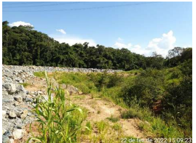
Foto 336 – Inspeção no bota-fora II da margem esquerda. (Data:22/02/2022)
