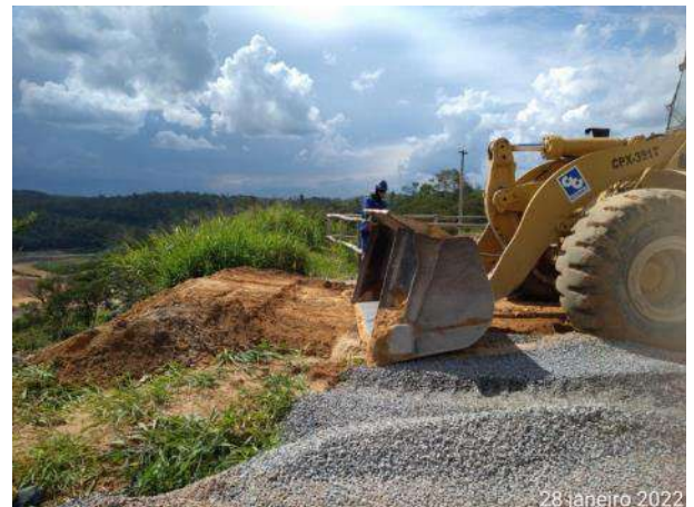
Foto 293 – Correção de erosão em talude próximo a usina de concreto. (Data:28/01/2022)
