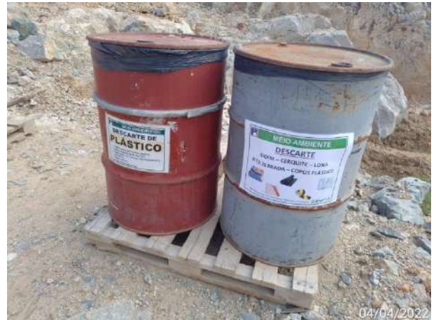
Foto 452 – Coletores de resíduos disponíveis na frente de serviço. (Data:04/04/2022)
