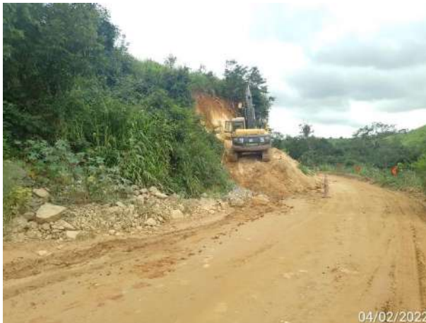
Foto 298 – Correção em talude do acesso a margem direita. (Data:04/02/2022)
