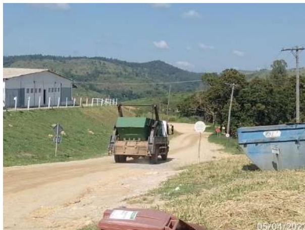
Foto 453 – Troca de caçambas de resíduo comum no canteiro operacional. (Data:05/04/2022)
