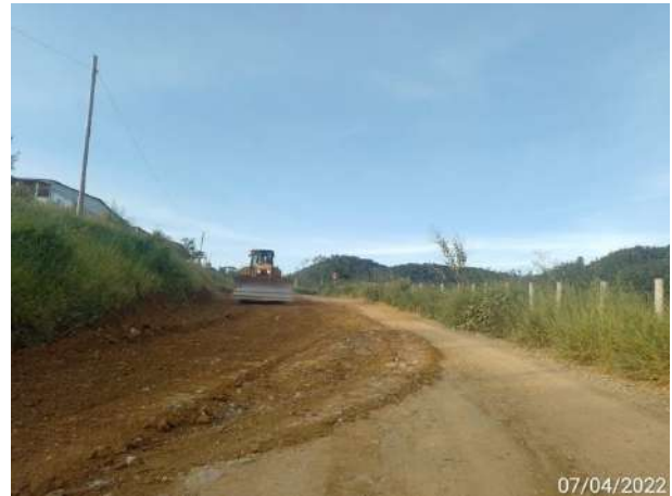
Foto 266 – Manutenção em via externa – MD01. (Data:07/04/2022)
