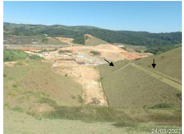
Foto 340 – Inspeção de drenagem definitiva na margem direita. (Data:24/03/2022)
