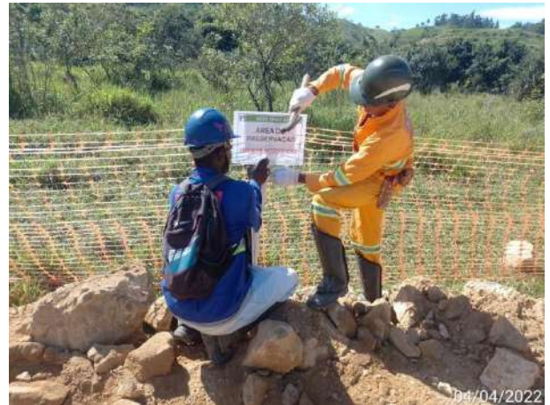
Foto 136 – Limpeza e organização no canteiro operacional. (Data:04/04/2022)
