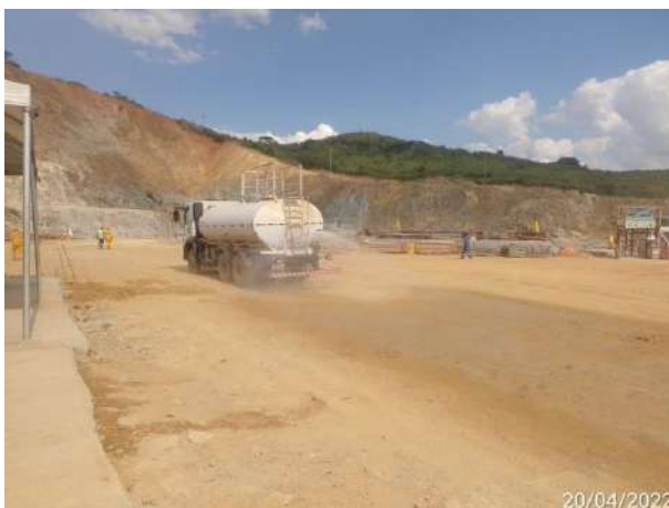
Foto 397 – Umectação nas vias internas. (Data:20/04/2022)
