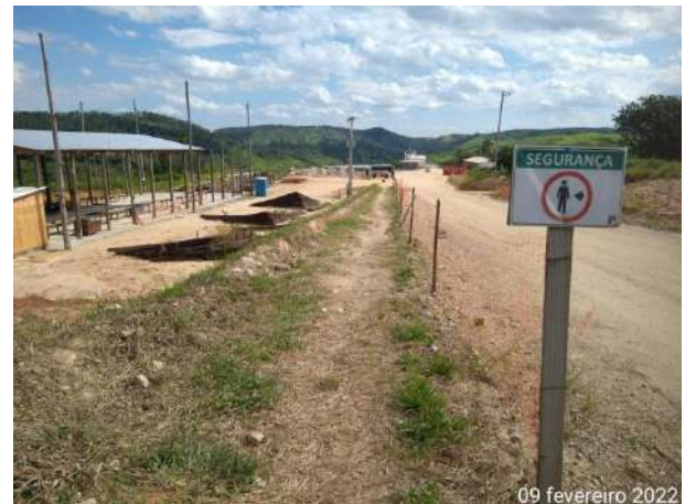
Foto 275 – Sinalização de caminho seguro no canteiro operacional. (Data:09/02/2022)
