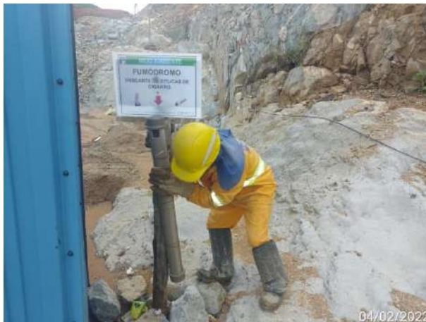
Foto 111 – Limpeza e organização das frentes de serviço da obra. (Data:04/02/2022)
