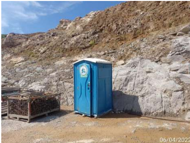
Foto 377 – Banheiro químico na frente de serviço. (Data:06/04/2022)
