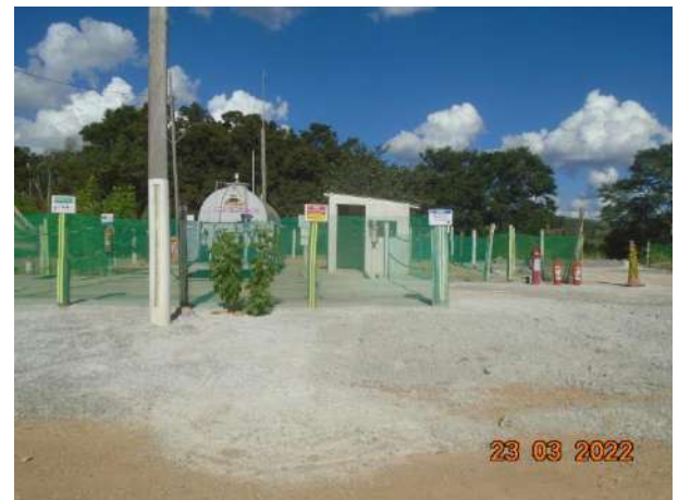
Foto 74 – Ponto de abastecimento. (Data:23/03/2022)
