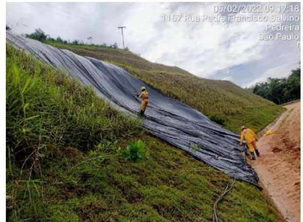
Foto 299 – Proteção de talude – M.D.03. (Data:05/02/2022)
