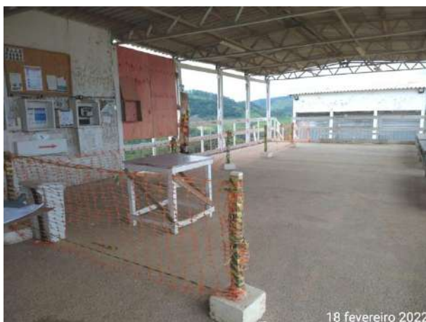
Foto 121 – Limpeza e organização na área de vivência. (Data:18/02/2022)
