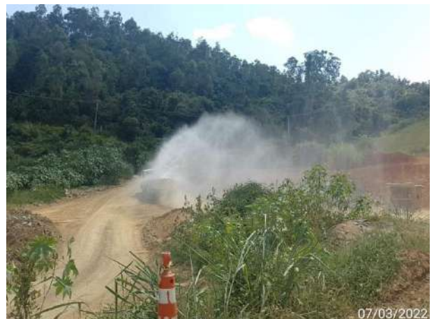
Foto 392 – Umectação nas vias internas. (Data:07/03/2022)
