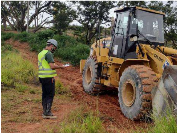
Foto 171 – Inspeção de equipamento. (Data:28/01/2022)
