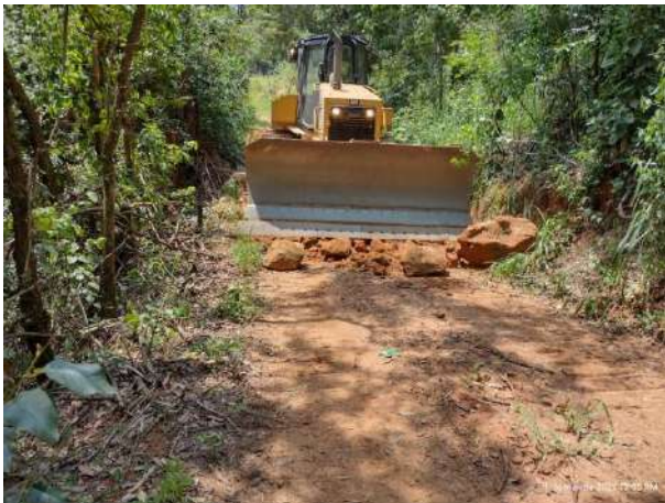
Foto 280 – Melhoria em via interna – lote 5 de plantio. (Data:01/03/2022)
