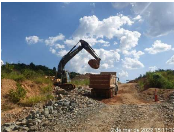
Foto 312 – Limpeza de drenagem ME. (Data:02/03/2022)
