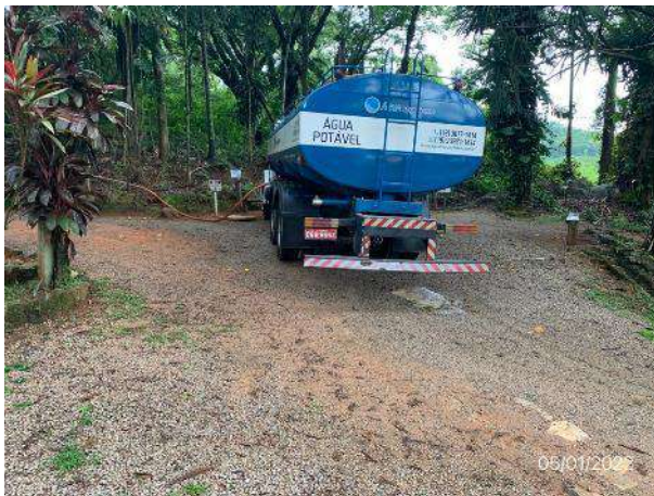
Foto 145 – Abastecimento da caixa de água do canteiro administrativo. (Data:05/01/2022)
