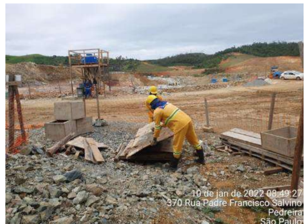
Foto 104 – Limpeza e organização nas frentes de serviços da obra. (Data:10/01/2022)
