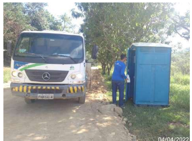
Foto 376 – Registro de higienização de banheiro químico na frente de serviço. (Data:04/04/2022)
