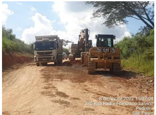
Foto 256 – Melhoramento de via externa – MD01. (Data:08/02/2022)
