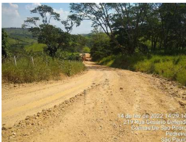
Foto 257 – Melhoramento de via externa – MD01. (Data:14/02/2022)
