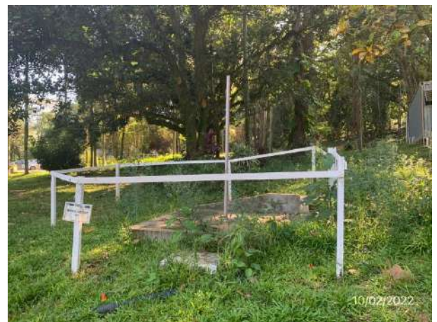
Foto 381 – Biodigestor 02 no canteiro administrativo. (Data:10/02/2022)
