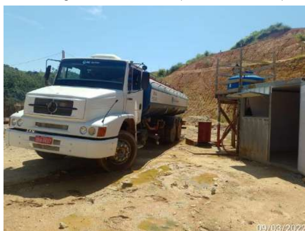
Foto 154 – Abastecimento da caixa de água das frentes de serviço. (Data:09/03/2022)
