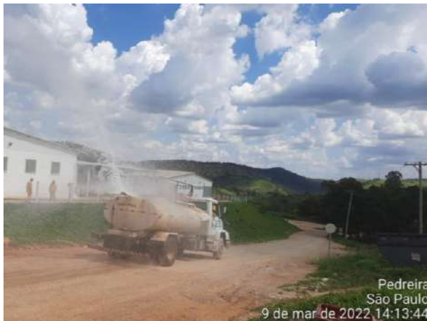
Foto 393 – Umectação nas vias internas. (Data:09/03/2022)
