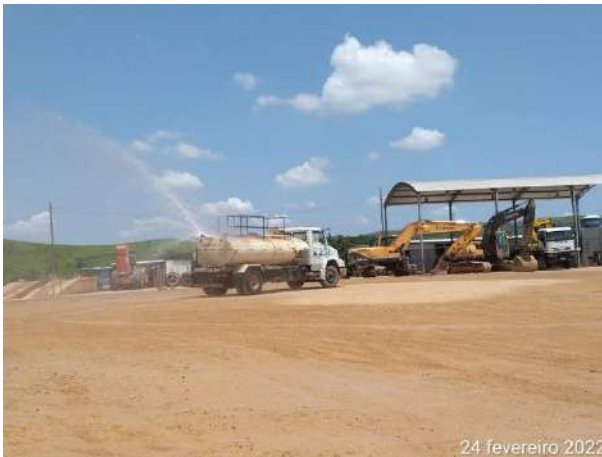
Foto 389 – Umectação nas vias internas. (Data:24/02/2022)
