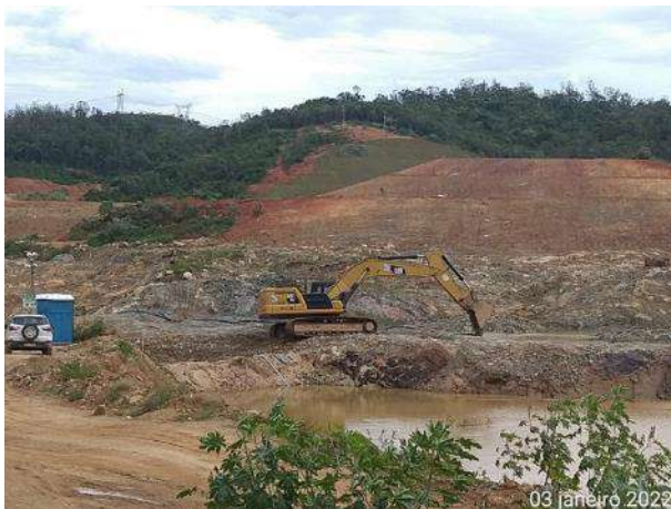
Foto 459 – Limpeza rigorosa margem direita. (Data:03/01/2022)
