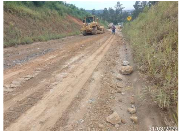
Foto 262 – Melhoramento de via externa – MD03. (Data:31/03/2022)
