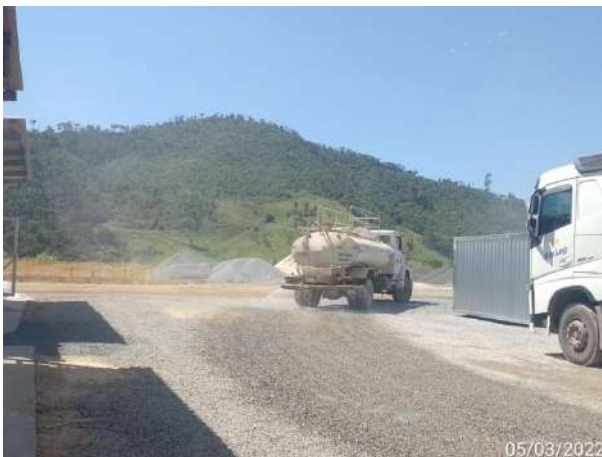
Foto 391 – Umectação nas vias internas. (Data:05/03/2022)
