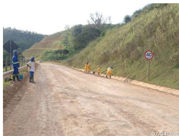
Foto 317 – Proteção de talude - MD03. (Data:07/04/2022)
