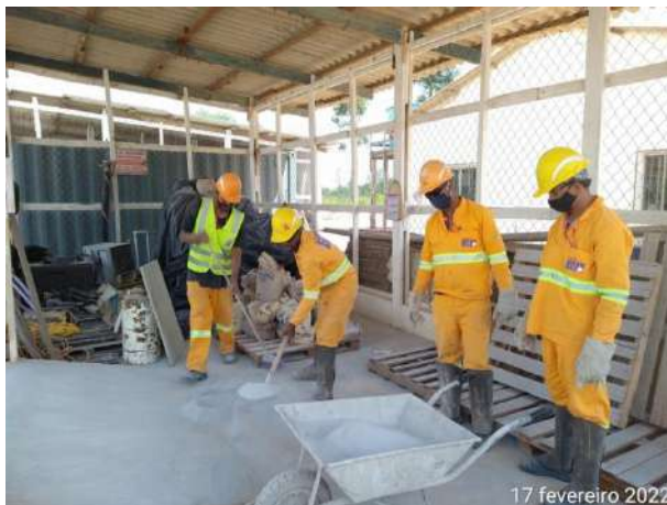
Foto 119 – Limpeza e organização na baía de materiais da usina de concreto. (Data:17/02/2022)
