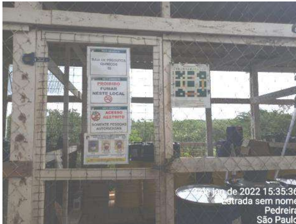
Foto 59 – Baía de produtos químicos no pátio da oficina mecânica. (Data:03/01/2022)
