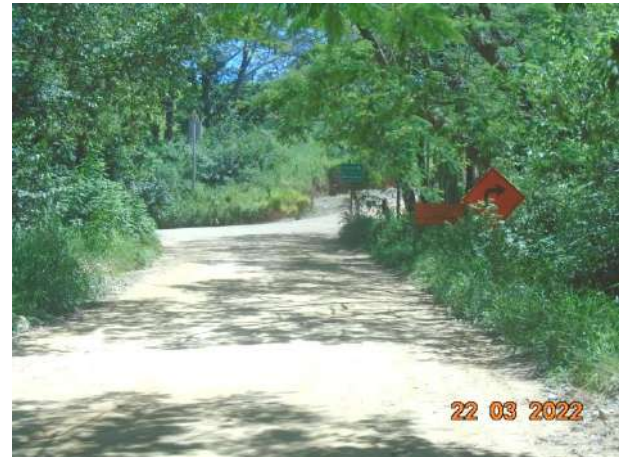
Foto 260 – Sinalização de entrada e saída de veículos pesados e curva acentuada a direita. Data: (22/03/2022)
