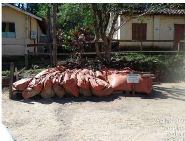
Foto 100 – Barreira de contenção ambiental. (Data:26/04/2022)
