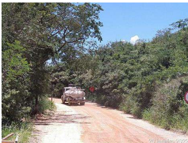
Foto 385 – Umectação nas vias internas. (Data:20/01/2022)
