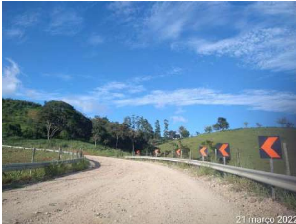
Foto 259 – Sinalização em via externa identificando curva a esquerda – MD03. (Data:21/03/2022)
