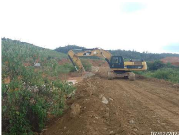
Foto 300 – Regularização de talude em via interna, acesso para margem direita. (Data:07/02/2022)
