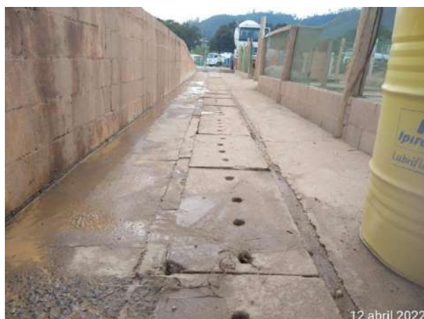
Foto 361 – Direcionamento caixa SÃO 02 no pátio da oficina mecânica. (Data:12/04/2022)
