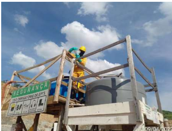
Foto 159 – Adequação de dosagem de cloro na fundação. (Data:09/04/2022)
