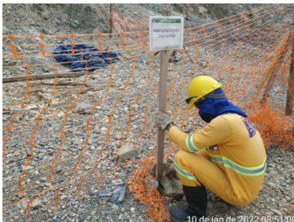
Foto 103 – Limpeza e organização das frentes de serviço da obra. (Data:10/01/2022)
