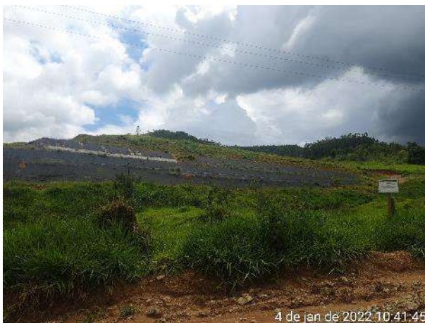
Foto 319 – Inspeção no bota-fora VII da margem direita, dia de chuva. (Data: 04/01/2022)
