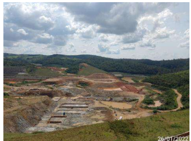
Foto 462 – Limpeza rigorosa margem direita. (Data:26/01/2022)
