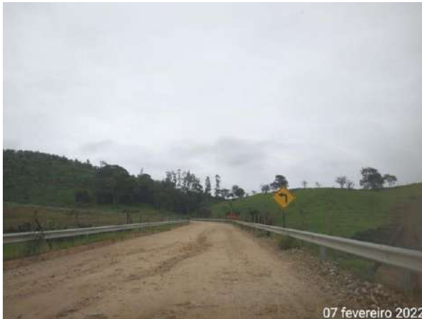
Foto 253 – Sinalização em via externa sobre curva acentuada a esquerda. (Data:07/02/2022)
