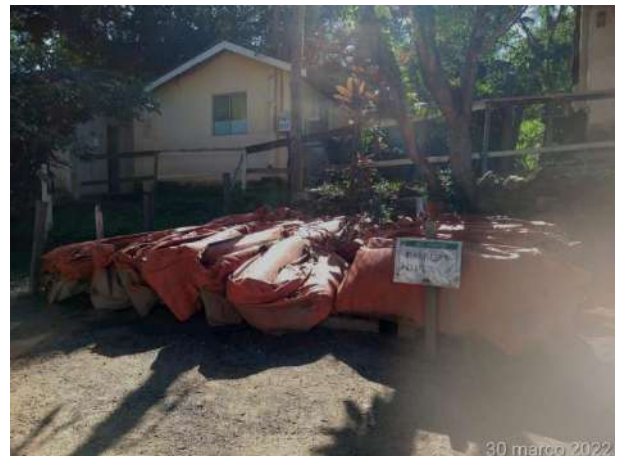
Foto 95 – Barreira de contenção ambiental no canteiro administrativo. (Data:30/03/2022)
