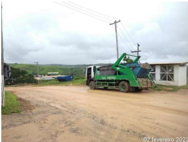
Foto 433 – Troca de caçambas de resíduo comum no canteiro operacional. (Data:02/02/2022)
