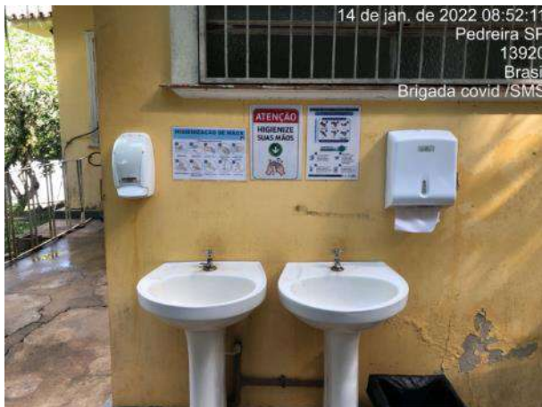
Foto 193 – Informativos nas pias para higienização das mãos no canteiro administrativo. (Data:14/01/2022).
