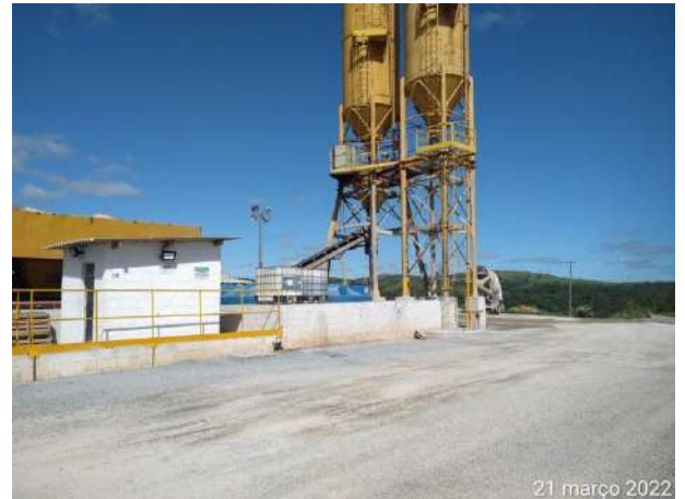
Foto 130 – Limpeza e organização na usina de concreto. (Data:21/03/2022)
