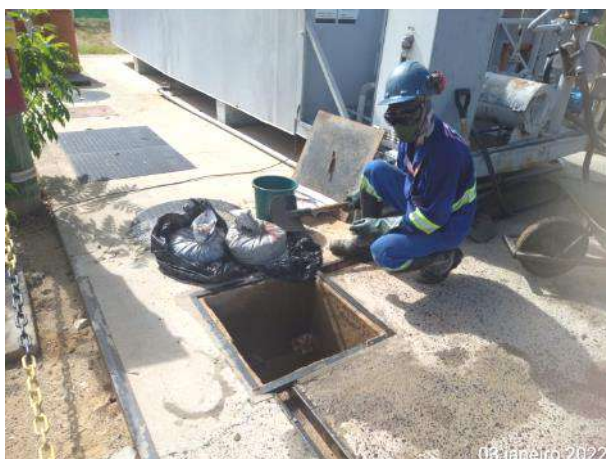
Foto 345 – Limpeza da caixa SAO 1 do ponto de abastecimento - pátio da oficina mecânica. (Data:03/01/2022)
