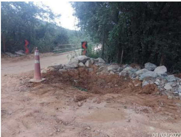
Foto 310 – Limpeza da drenagem na ME. (Data:01/03/2022)
