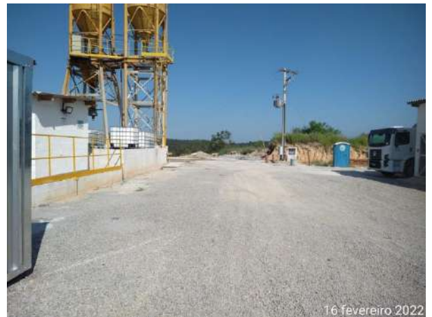
Foto 118 – Limpeza e organização nas frentes de serviços. (Data:16/02/2022)
