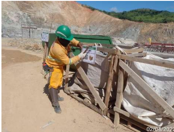
Foto 135 – Limpeza e organização na frente de serviço. (Data:02/04/2022)
