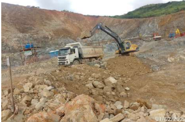
Foto 463 – Limpeza rigorosa margem direita. (Data:01/02/2022)
