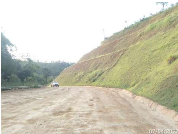
Foto 341 – Inspeção em talude – MD03. (Data: 07/04/2022)
