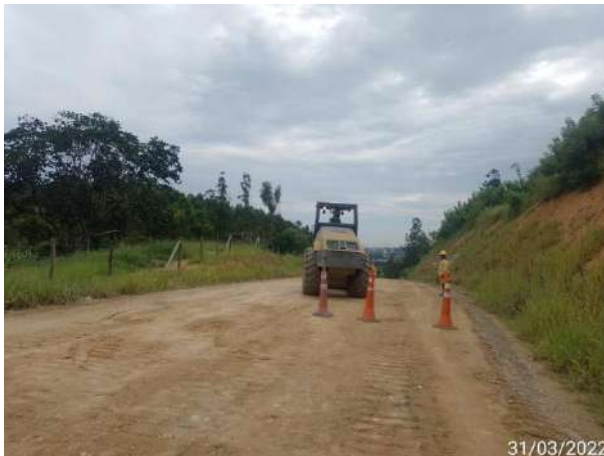
Foto 261 – Manutenção em via externa – MD03. (Data:31/03/2022)
