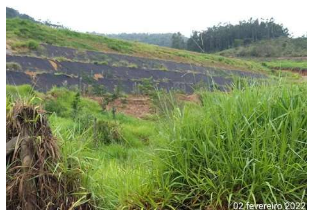
Foto 330 – Inspeção em dia de chuva – bota-fora VII. (Data: 02/02/2022)
