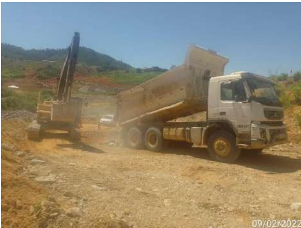
Foto 465 – Limpeza rigorosa margem direita. (Data:09/02/2022)
