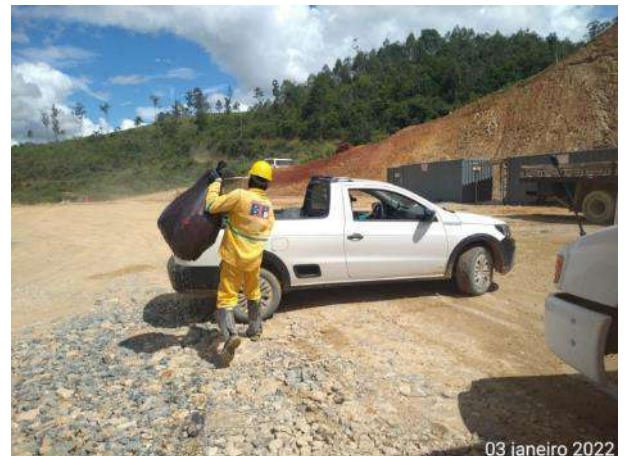
Foto 102 – Limpeza e organização das frentes de serviço da obra. (Data:03/01/2022)
