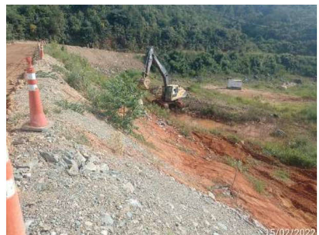
Foto 307 – Correção de erosão no talude da enseadeira J1. (Data:15/02/2022)
