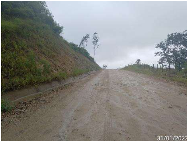
Foto 327 – Monitoramento no acesso MD03, em dia de chuva. (Data:31/01/2022)
