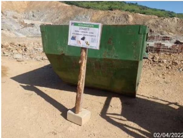
Foto 451 – Caçamba de resíduo comum disponível na frente de serviço. (Data:02/04/2022)
