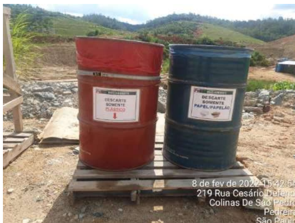
Foto 437 – Coletores de resíduos recicláveis disponíveis nas frentes de serviço. (Data:08/02/2022).
