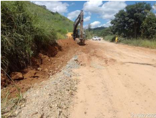
Foto 308 – Melhoria do direcionamento de água na margem direita. (Data:21/02/2022)
