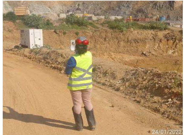
Foto 402 – Medição de fumaça preta em gerador. (Data:24/01/2022)
