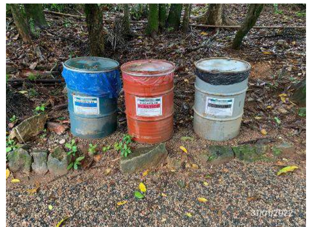
Foto 432 – Coletores de resíduos disponíveis no canteiro administrativo. (Data:31/01/2022).
