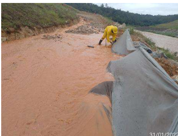
Foto 294 – Implantação de barreira para direcionamento de água no acesso ME. (Data:31/01/2022)
