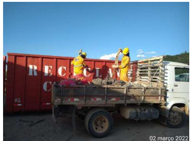
Foto 126 – Limpeza e organização no canteiro operacional. (Data:02/03/2022)
