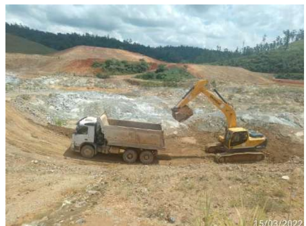
Foto 468 – Limpeza rigorosa margem direita. (Data:15/03/2022)
