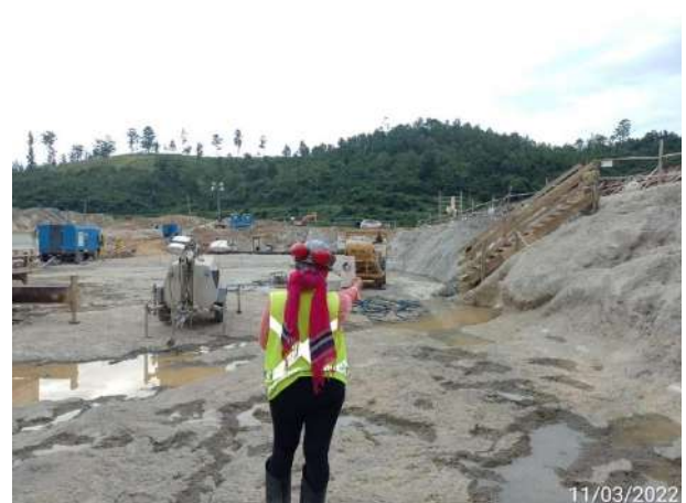
Foto 410 – Medição de fumaça em compressor. (Data:11/03/2022)
