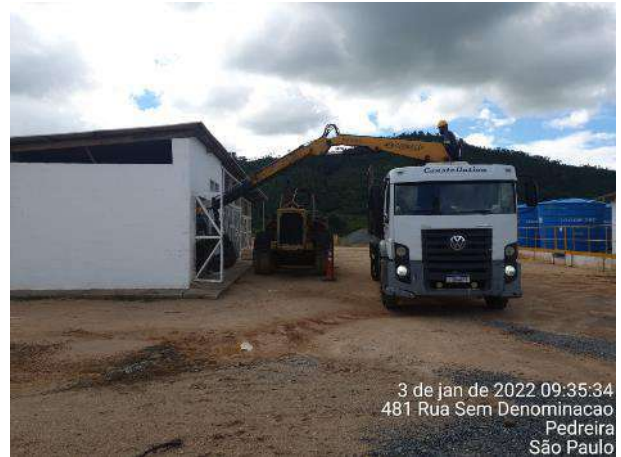
Foto 82 – Retirada de resíduos perigosos. (Data:03/01/2022)
