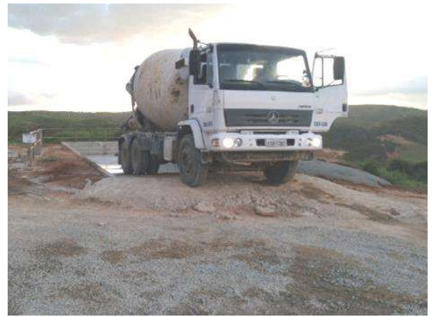
Foto 350 – Lavagem de calha de betoneira – usina de concreto. (Data:31/01/2022)
