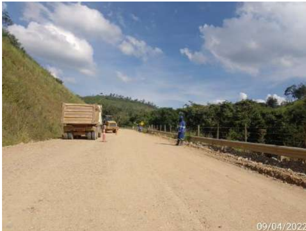
Foto 267 – Manutenção em via externa – MD03. (Data:09/04/2022)
