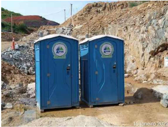
Foto 365 – Banheiro químico na frente de serviço da margem direita. (Data:15/01/2022)
