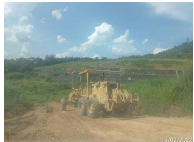
Foto 277 – Melhoramento de via interna – margem direita. (Data:16/02/2022)
