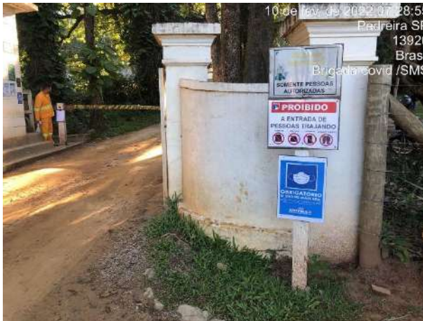
Foto 199 – Informativos na entrada do canteiro administrativo. (Data:10/02/2022).
