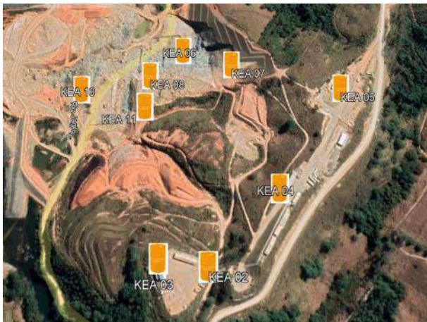
Figura 7 – Indicação dos kits de emergência ambiental na margem direita.
