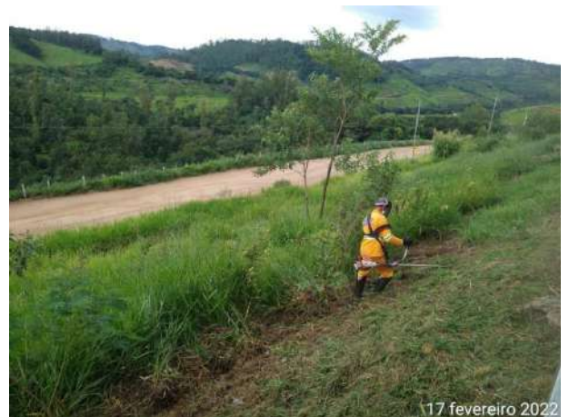
Foto 120 – Roçagem no canteiro industrial. (Data:07/02/2022)
