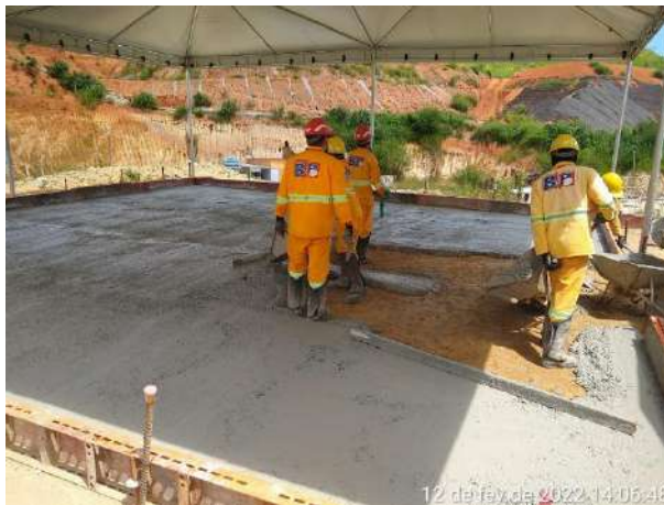
Foto 163 – Sobra de concreto utilizado para piso da área de vivência. (Data:12/02/2022)
