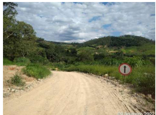
Foto 273 – Sinalização interna de sentido de via. (Data:09/02/2022)
