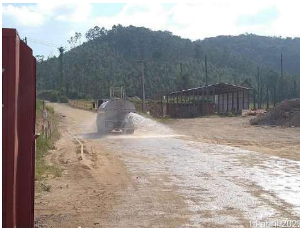
Foto 395 – Umectação nas vias internas. (Data:14/04/2022)
