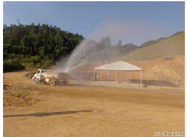
Foto 390 – Umectação nas vias internas. (Data:28/02/2022)
