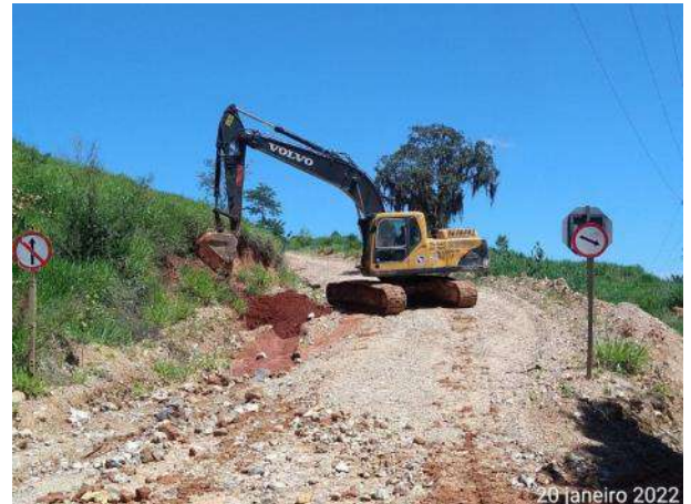
Foto 291 – Implantação de cacimba para reduzir a velocidade da água no acesso da margem esquerda. (Data:20/01/2022)
