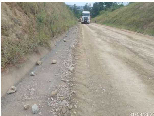
Foto 263 – Melhoramento de via externa – MD03. (Data:31/03/2022)
