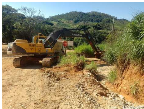
Foto 306 – Limpeza de cacimba no acesso ao canteiro industrial. (Data:10/02/2022)
