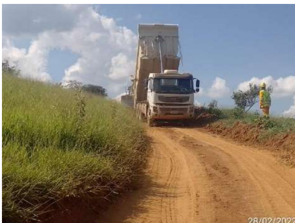
Foto 278 – Melhoramento em via interna – lote 7. (Data:28/02/2022)
