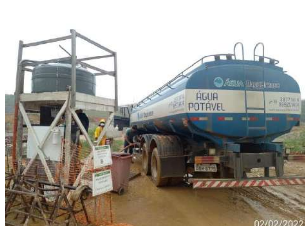
Foto 150 – Abastecimento da caixa de água nas frentes de serviço. (Data:02/02/2022)
