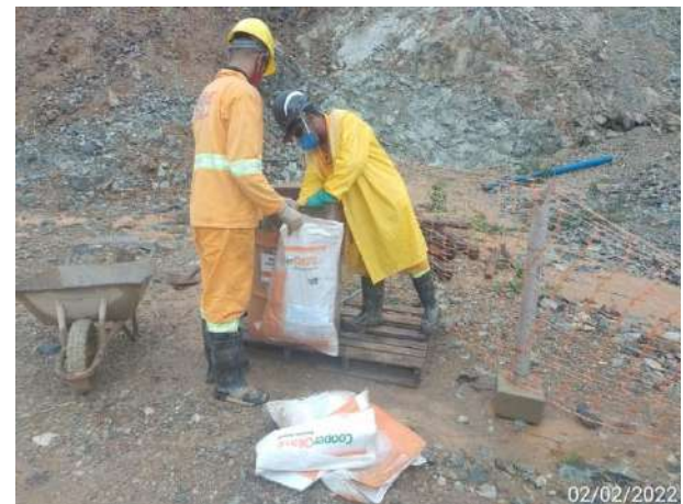
Foto 87 – Retirada de resíduos perigosos. (Data:02/02/2022)
