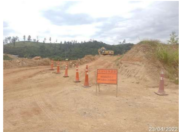
Foto 287 – Sinalização durante atividade no acesso a fundação. (Data:23/04/2022)
