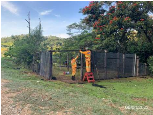
Foto 137 – Limpeza e organização no canteiro administrativo. (Data:06/04/2022)
