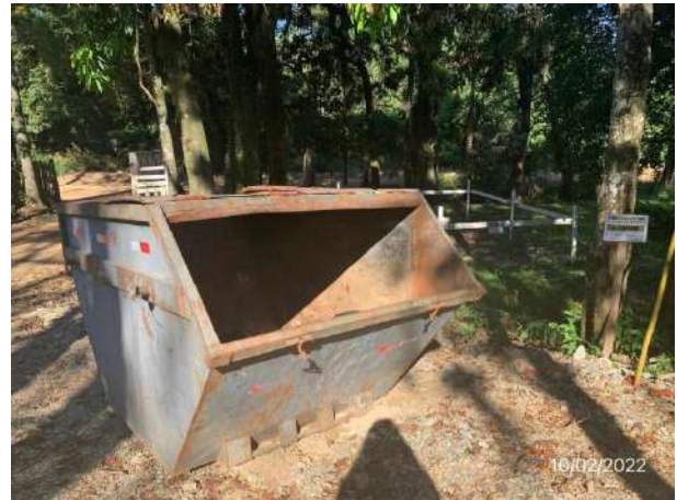
Foto 440 – Caçamba de resíduo comum disponível no canteiro administrativo. (Data:10/02/2022).
