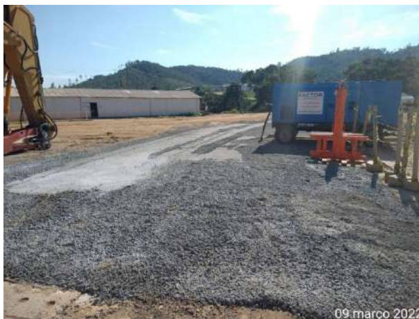
Foto 165 – Sobra de concreto utilizado para piso do pátio da oficina mecânica. (Data:09/03/2022)
