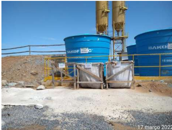
Foto 129 – Limpeza e organização na usina de concreto. (Data:17/03/2022)
