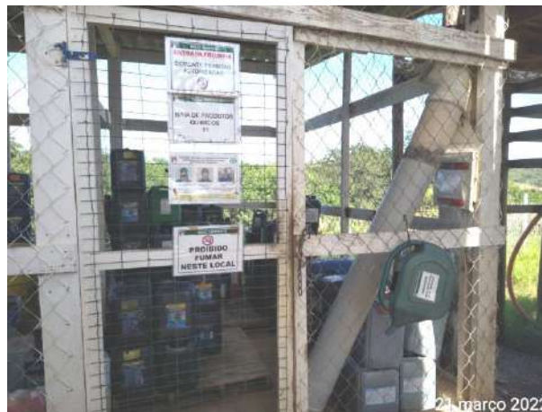
Foto 73 - Baía de produtos químicos no pátio da oficina mecânica. (Data:21/03/2022)
