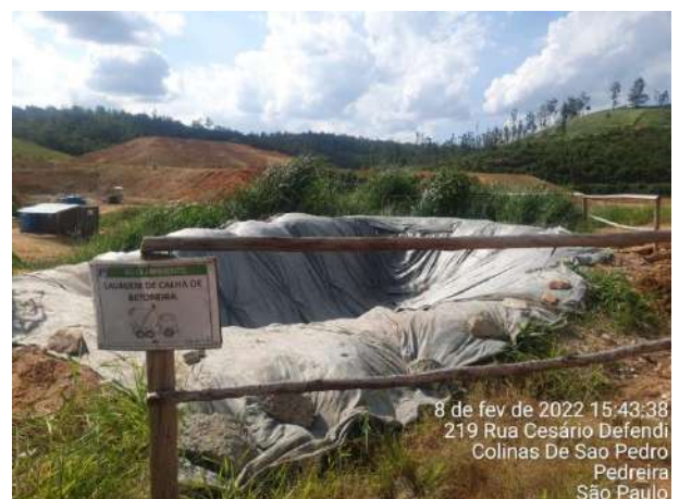
Foto 352 – Área para lavagem de calha de betoneira – margem direita. (Data:08/02/2022)
