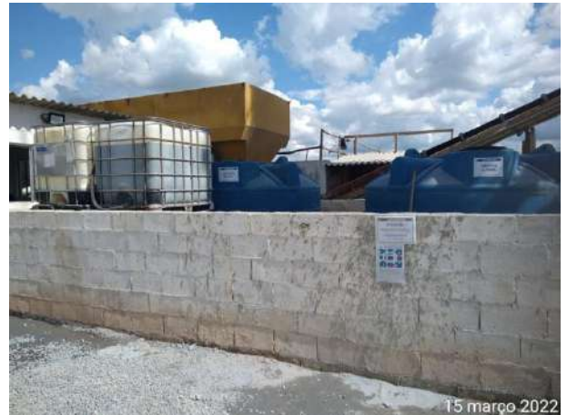
Foto 72 – Aditivos da usina de concreto, dentro da área de contingência. (Data:15/03/2022)
