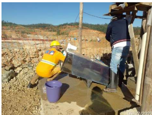
Foto 151 – Higienização de bebedouro nas frentes de serviço. (Data:09/02/2022)
