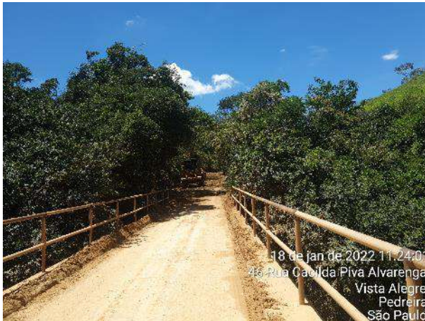
Foto 290 – Melhoramento do direcionamento de água na margem esquerda. (Data:18/01/2022)
