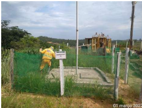
Foto 123 – Limpeza e organização no biodigestor no canteiro operacional. (Data:01/03/2022)
