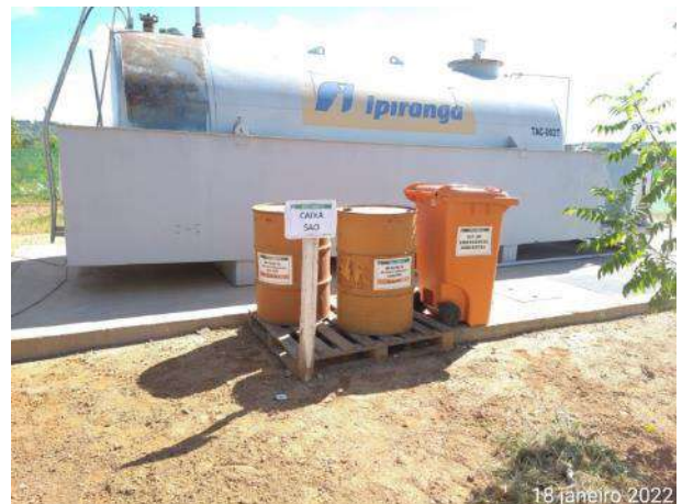
Foto 84 – Kit de emergência ambiental na frente de serviço. (Data:18/01/2022)
