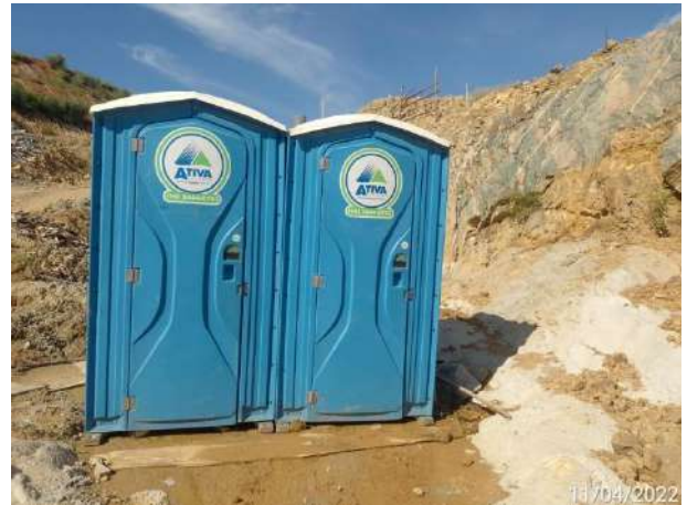
Foto 378 – Higienização de banheiro químico na frente de serviço. (Data:11/04/2022)
