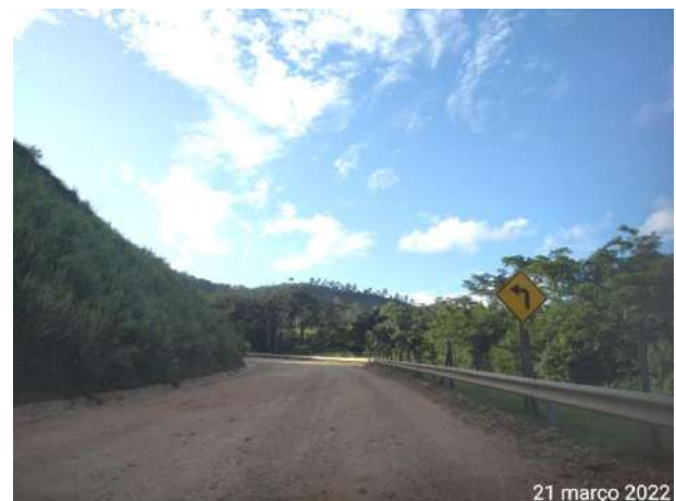
Foto 258 – Sinalização de curva acentuada a esquerda - MD03 Data: (21/03/2022)
