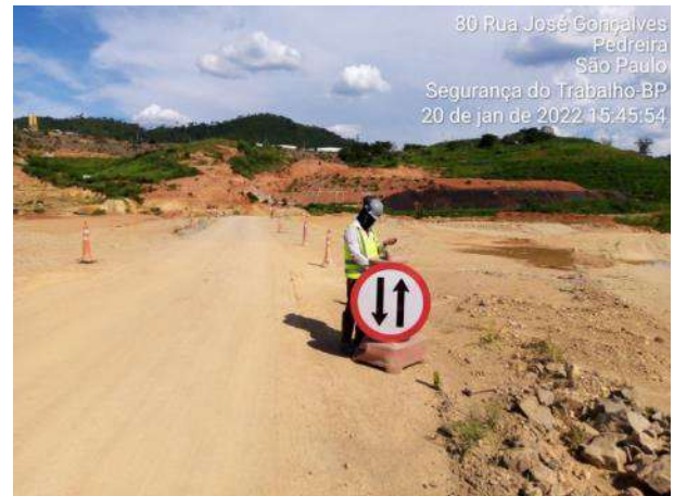
Foto 269 – Sinalização de sentido duplo de via. (Data:20/01/2022)
