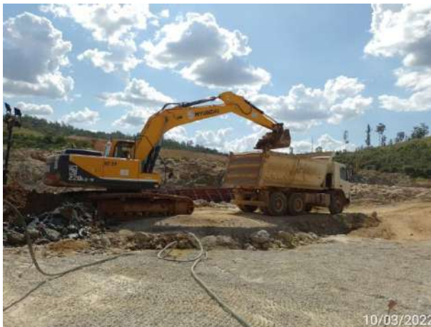
Foto 471 – Limpeza rigorosa margem direita. (Data:10/03/2022)
