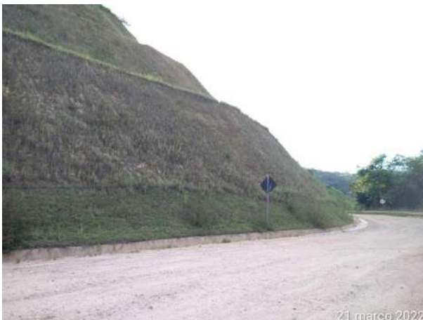
Foto 337 – Inspeção em talude – MD03. (Data: 21/03/2022)
