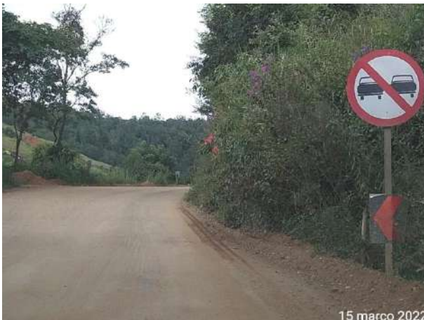
Foto 282 – Sinalização interna de proibido ultrapassagem. (Data:15/03/2022)
