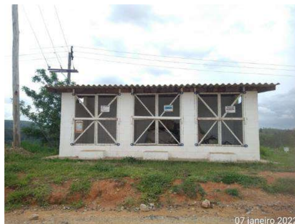
Foto 426 – Baias para recicláveis no canteiro operacional. (Data:07/01/2022).
