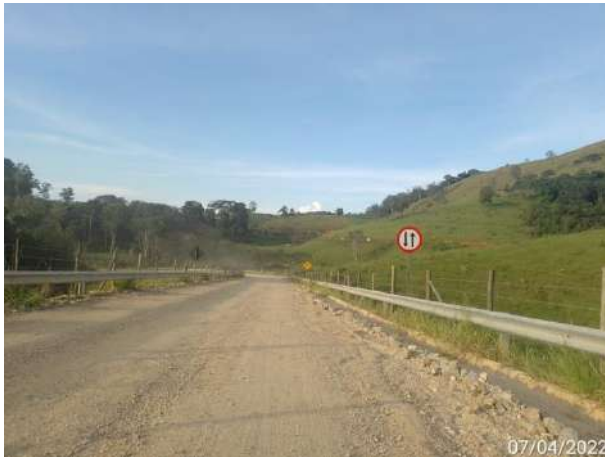
Foto 265 – Sinalização em via externa de mão dupla – MD03. (Data:07/04/2022)
