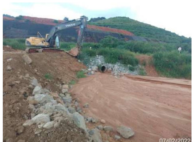
Foto 301 – Regularização de talude em via interna - margem direita. (Data:07/02/2022)
