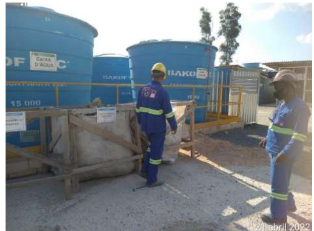
Foto 142 – Limpeza e organização na usina de concreto. (Data:21/04/2022)
