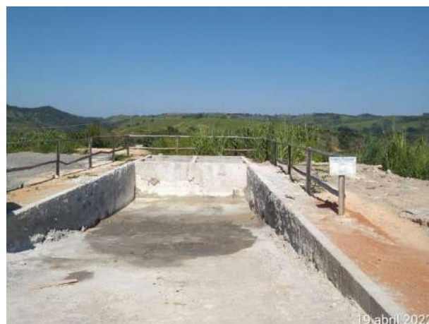
Foto 360 – Área para lavagem de calha de betoneira – usina de concreto. (Data:19/04/2022)
