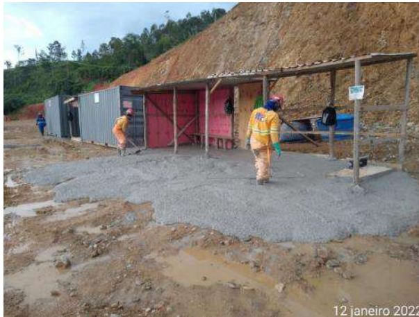
Foto 161 – Sobra de concreto para piso em área de vivência. (Data:12/01/2022)
