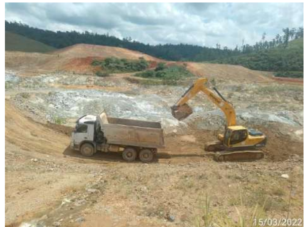
Foto 472 – Limpeza rigorosa margem direita. (Data:15/03/2022)
