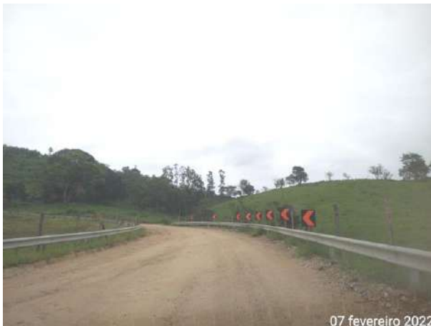
Foto 255 – Sinalização de setas em via externa. (Data:07/02/2022)
