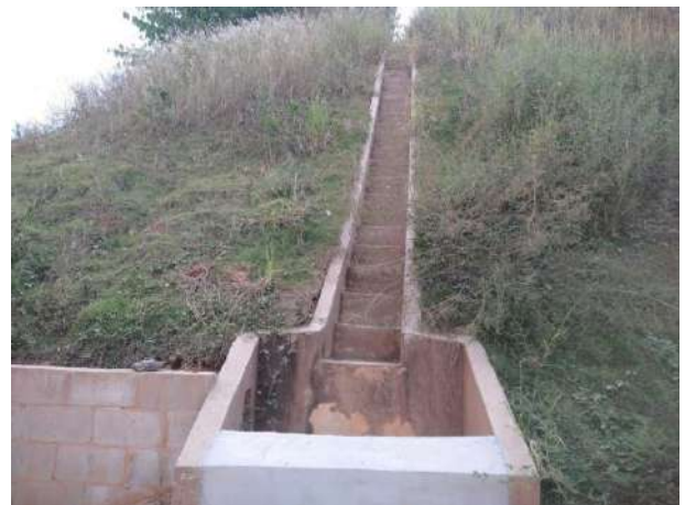
Foto 344 – Inspeção de escada hidráulica na MD-03. (Data:29/04/2022)
