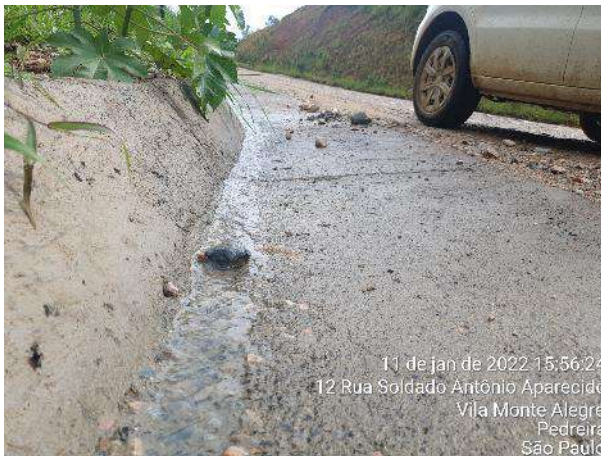
Foto 323 – Monitoramento de drenagem na M.D.03, dia de chuva. (Data:11/01/2022)
