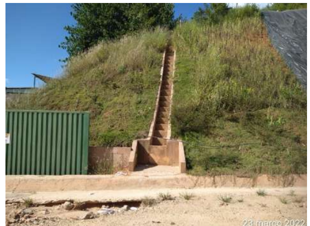
Foto 338 – Inspeção escada hidráulica – M.D.03. (Data:23/03/2022)
