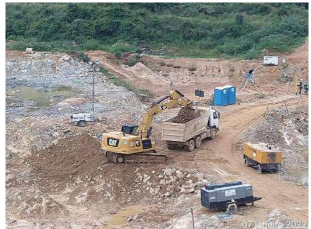
Foto 460 – Limpeza rigorosa margem direita. (Data:07/01/2022)
