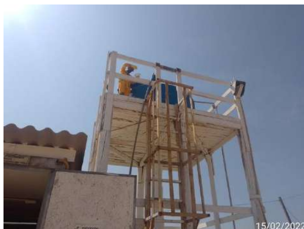
Foto 152 – Adequação de dosagem de cloro na caixa de água do laboratório. (Data:15/02/2022)
