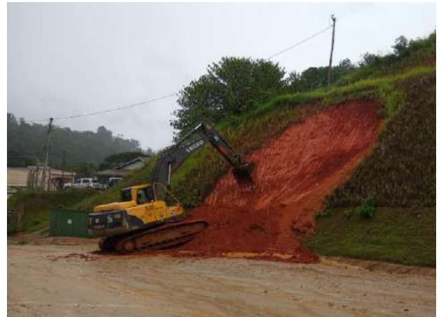
Foto 297 – Regularização de talude – MD03. (Data:04/02/2022)
