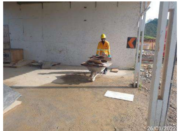
Foto 106 – Limpeza e organização nas frentes de serviços. (Data:26/01/2022)
