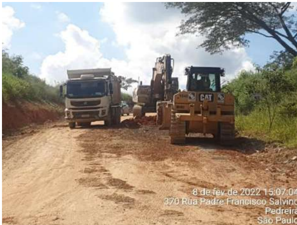
Foto 304 – Implantação de drenagem no acesso para o canteiro industrial. (Data:08/02/2022)
