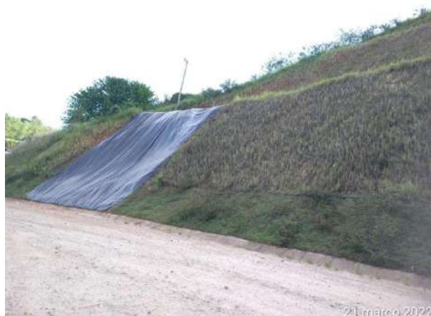
Foto 314 – Proteção de talude - MD03. (Data:21/03/2022)
