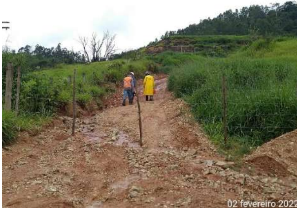
Foto 329 – Inspeção em dia de chuva – bota-fora III. (Data: 02/02/2022)
