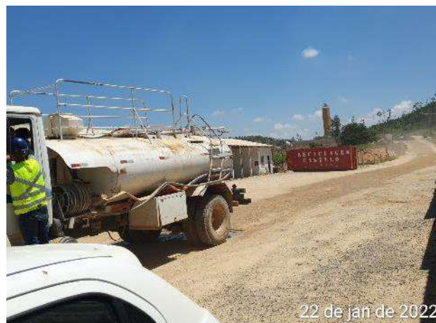
Foto 386 – Umectação nas vias internas. (Data:22/01/2022)
