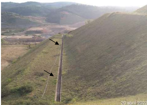
Foto 343 – Inspeção de drenagem definitiva na margem direita. (Data:20/04/2022)
