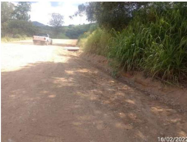
Foto 335 – Inspeção em drenagem provisória MD 01. (Data:16/02/2022)
