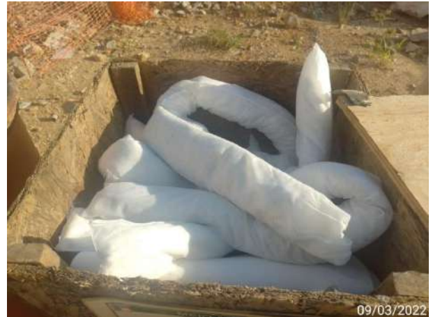
Foto 91 – Kit de emergência ambiental na frente de serviço. (Data:09/03/2022)
