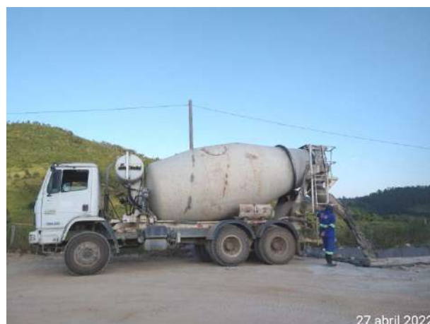
Foto 362 – Área para lavagem de calha de betoneira – canteiro operacional. (Data:27/04/2022)
