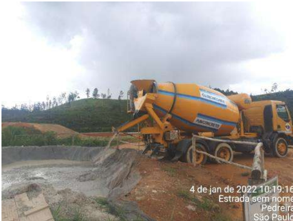
Foto 347 – Área para lavagem de calha de betoneira – margem direita. (Data:04/01/2022)
