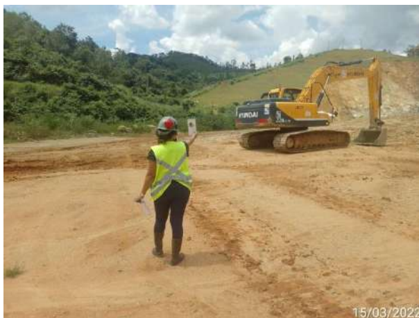
Foto 411 – Medição de fumaça preta em retroscavadeira. (Data:15/03/2022)
