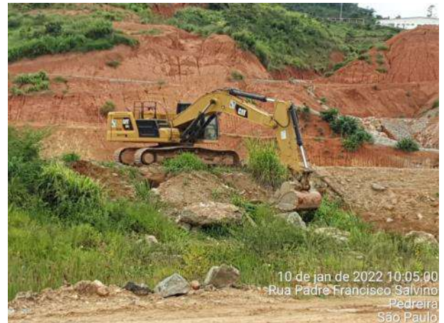
Foto 289 – Correção de erosão no talude na margem direita. (Data:10/01/2022)
