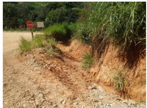
Foto 332 – Inspeção em drenagem provisória – MD01. (Data: 11/02/2022)
