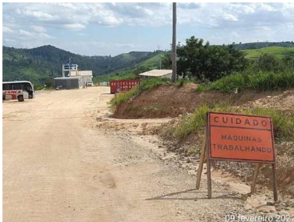
Foto 274 – Sinalização de máquinas trabalhando no local. (Data:09/02/2022)
