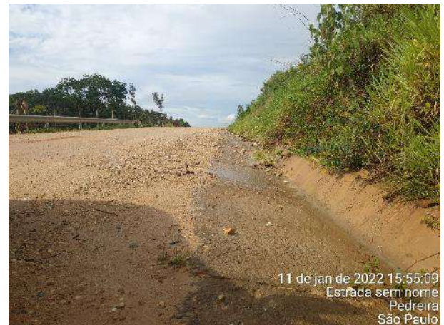
Foto 324 – Monitoramento de drenagem na M.D.03, dia de chuva. (Data:11/01/2022)
