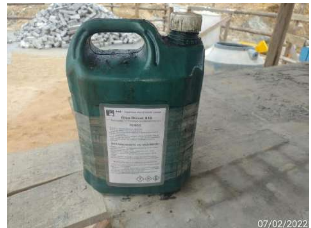
Foto 68 – Produto devidamente rotulado – ombreira direita. (Data:07/02/2022)
