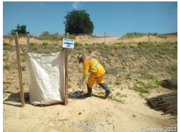
Foto 124 – Limpeza e organização no canteiro operacional. (Data:02/03/2022)
